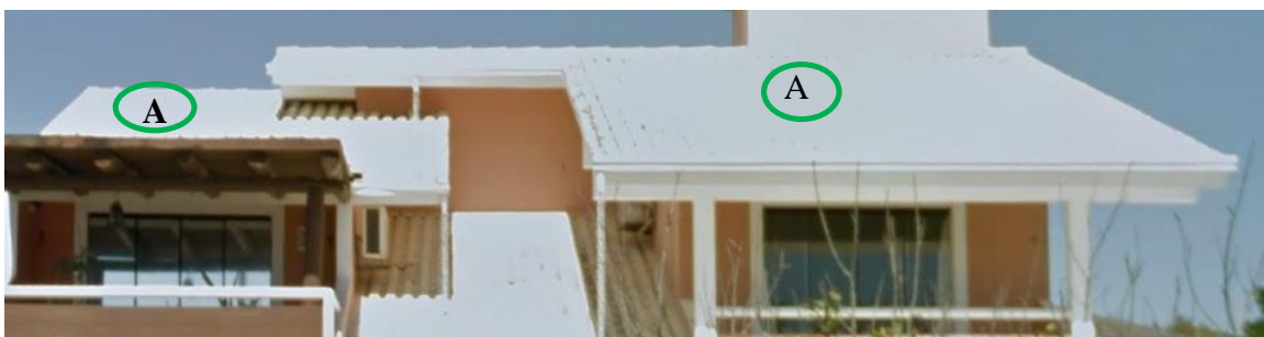
Figura 24 - Área para instalação dos painéis. Fonte: Autoria própria.
