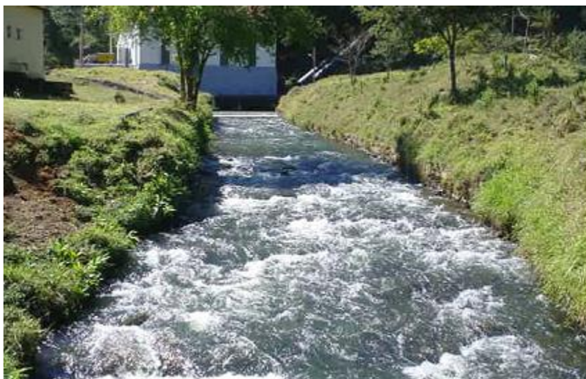
Figura 20 – Canal de Fuga. Fonte: STANO JÚNIOR, (2008).
