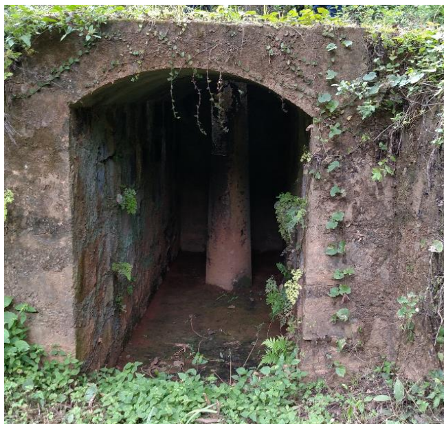
Figura 42 – Canal de fuga existente. Fonte: Autoria própria.
