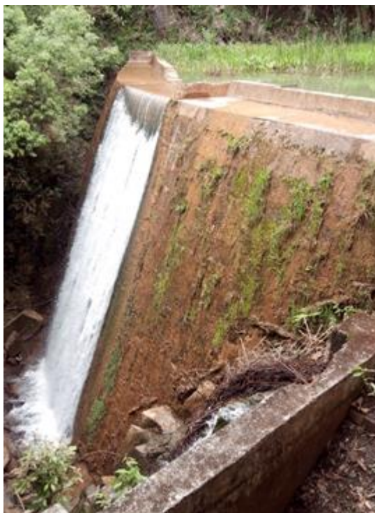
Figura 1 – Barragem da micro central hidrelétrica de Rio Branco Fonte: Autoria Própria.
