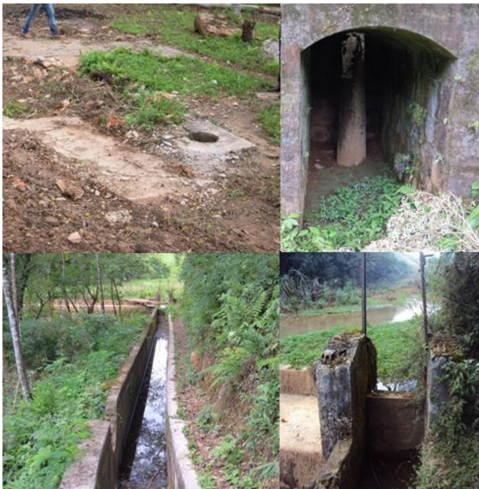
Figura 24 - Instalações da Usina Rancharia Fonte: Autoria própria.
