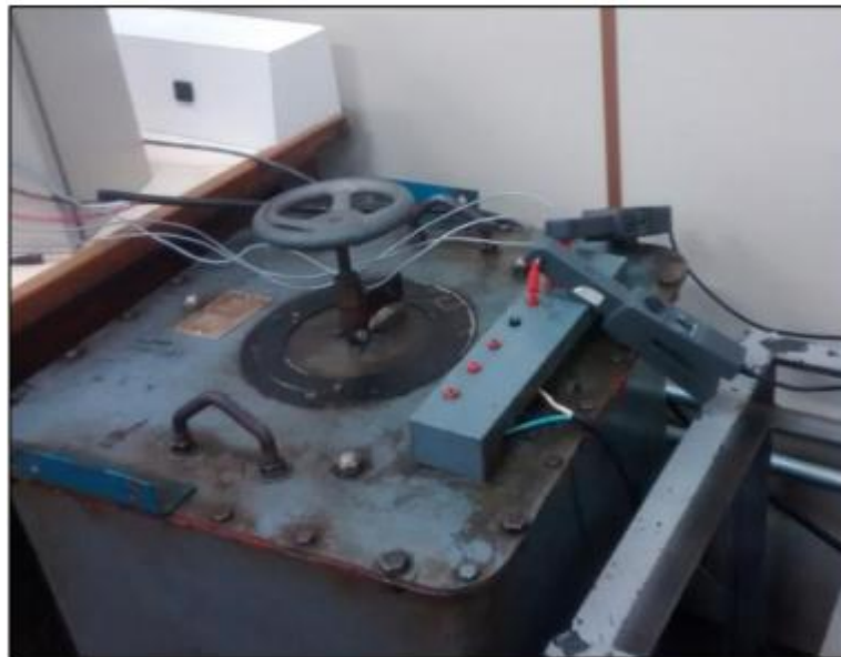
Figura 21: Variador de tensão trifásico Fonte: Autoria Própria.
