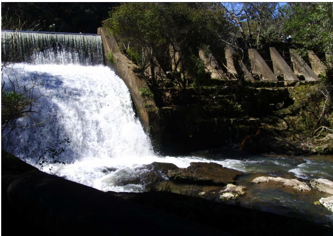
Figura 18: Vista 1 da barragem - MCH Roncador
