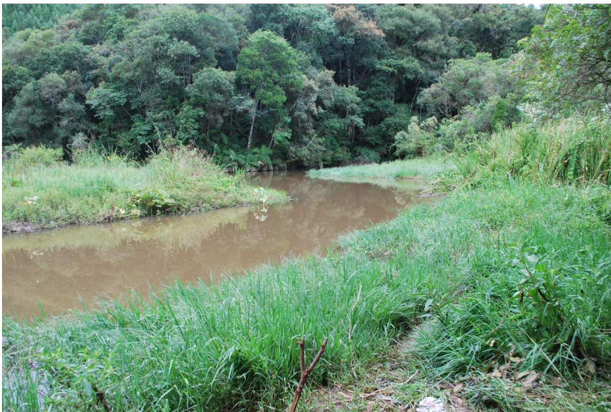
Figura 12: Reservatório MCH Roncador
