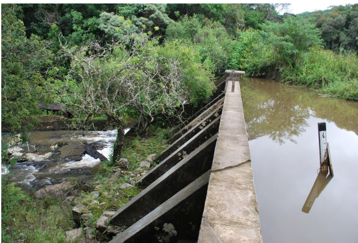
Figura 19: Vista 2 da barragem - MCH Roncador
