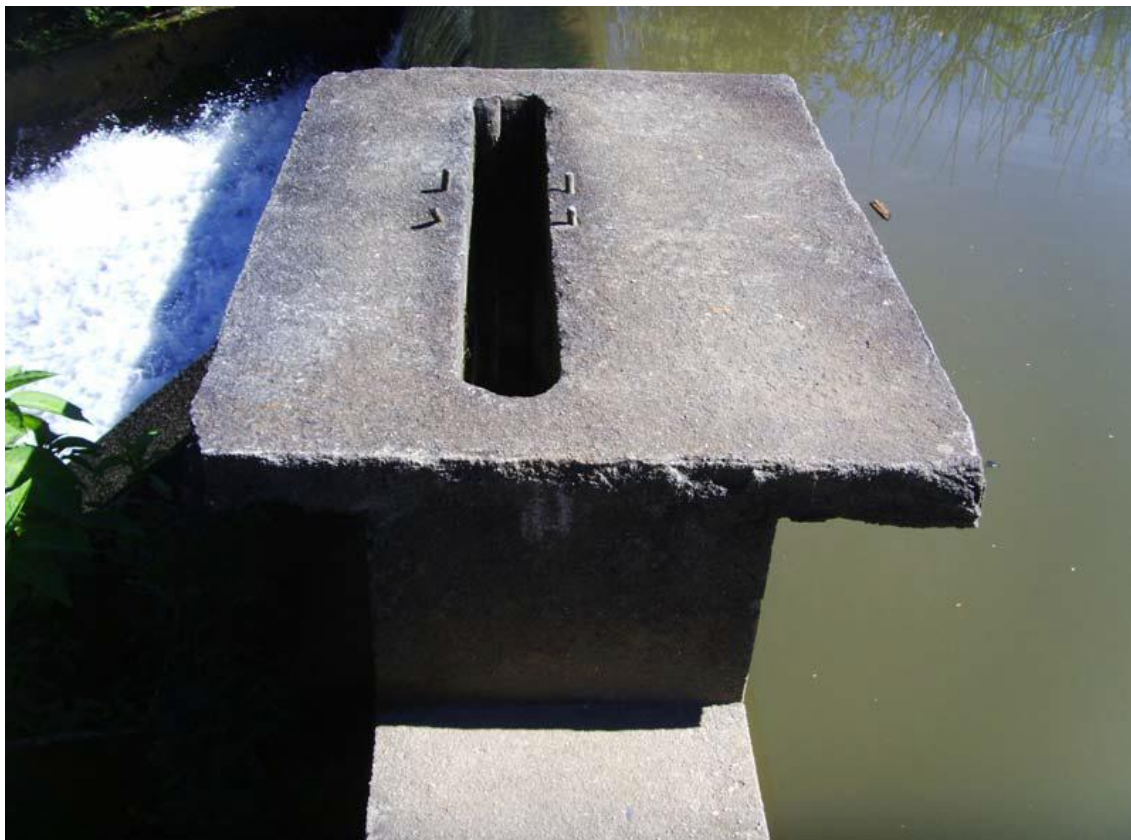
Figura 29 – Extravasador - MCH Roncador
