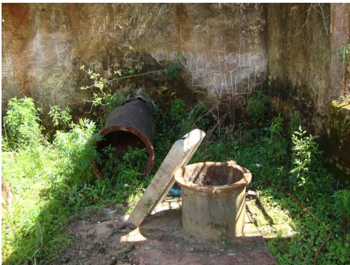
Figura 27: Canal de fuga - MCH Roncador
