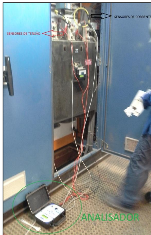
Figura 19 - Instalação do analisador de energia RE7000TM.
