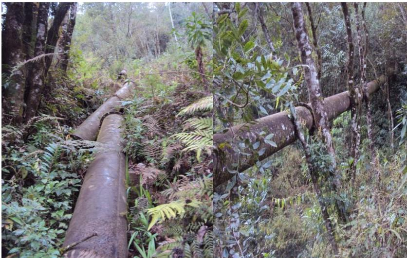
**Figura 22 – Conduto forçado da MCH de Rio Branco do Sul.
