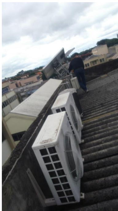
Figura 19 Terraço do bloco B da UTFPR Fonte: Acervo da autora
