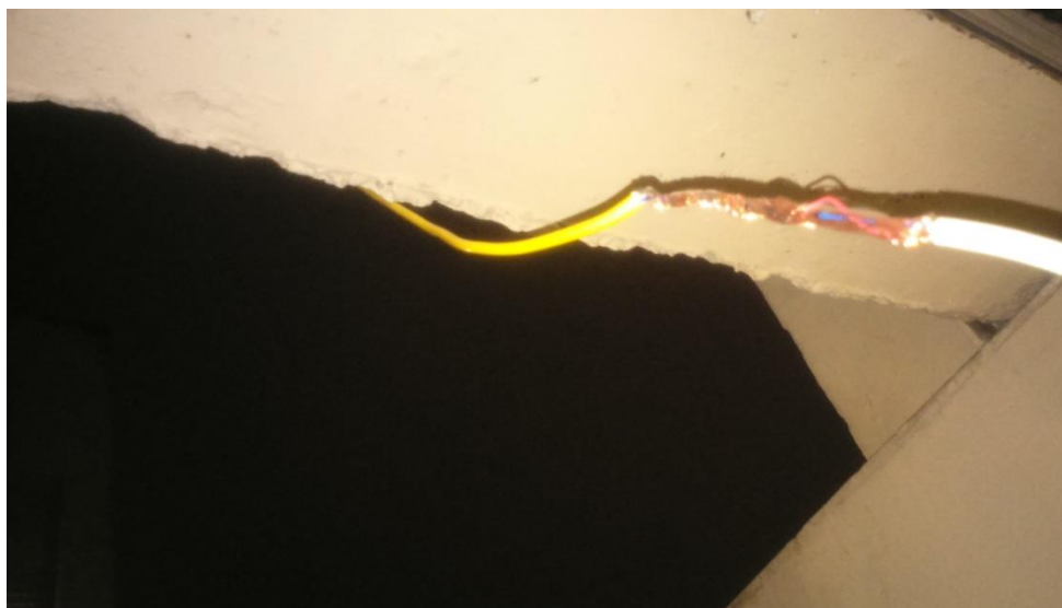
Figura 41 Malhas de proteção dos cabos unidas Fonte: Acervo da Autora
