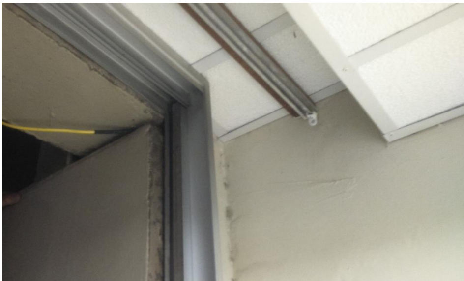
Figura 42 Cabo passado pelo vão da janela da sala B207 Fonte Acervo da Autora
