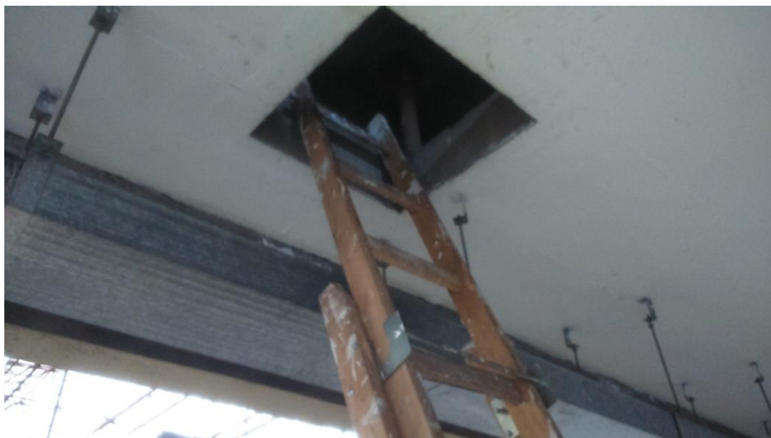
Figura 23 Alçapão de acesso ao terraço do bloco B Fonte: Acervo da autora
