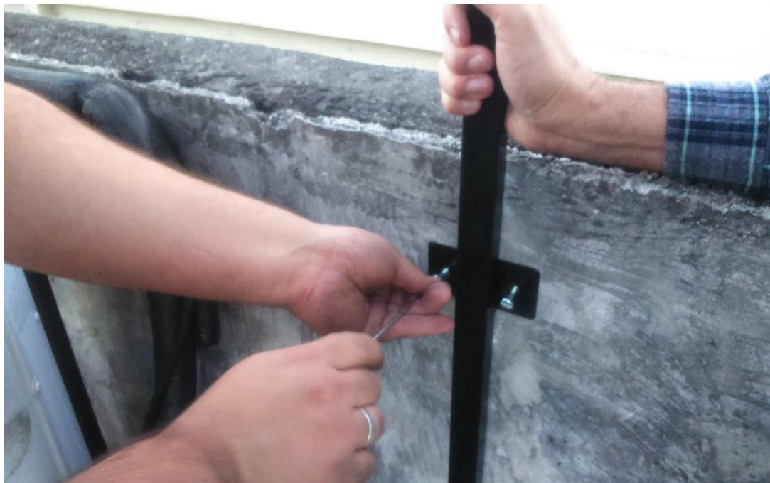
Figura 33 Fixação do suporte furos superiores Fonte: Acervo da Autora
