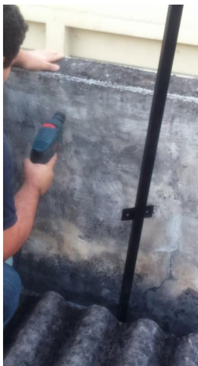
Figura 32 Confeção dos dois primeiros furos na parede (b) Fonte: Acervo da Autora
