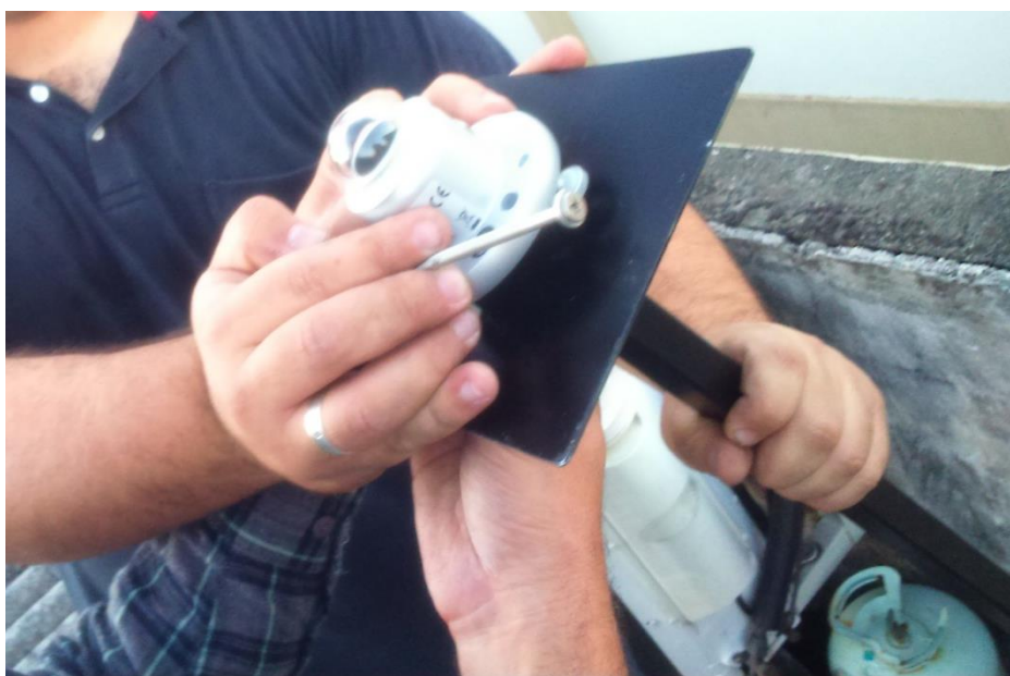
Figura 29 Marcação do suporte para a furação Fonte: Acervo da Autora
