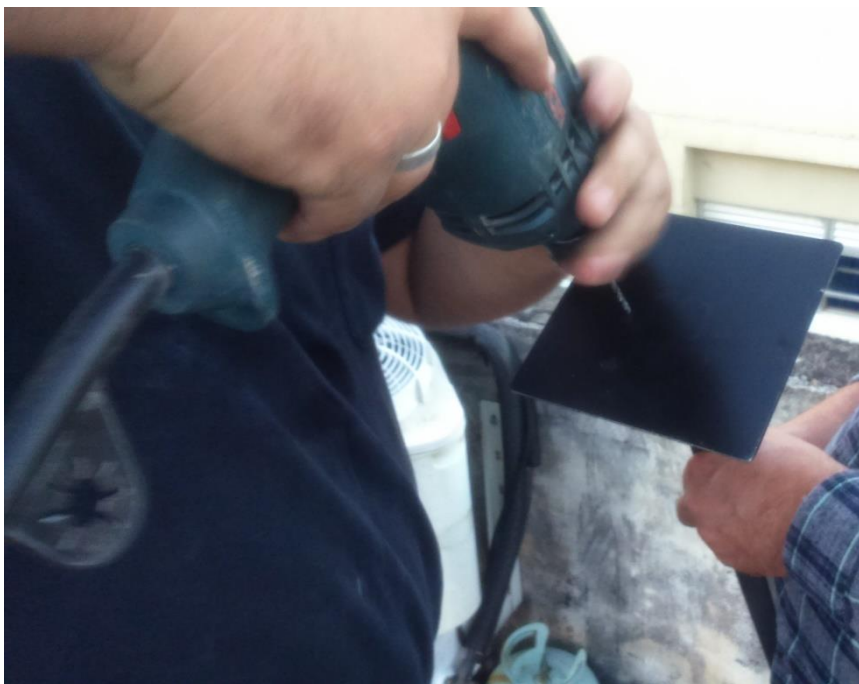
Figura 30 Confeção do furo no suporte Fonte: Acervo da Autora
