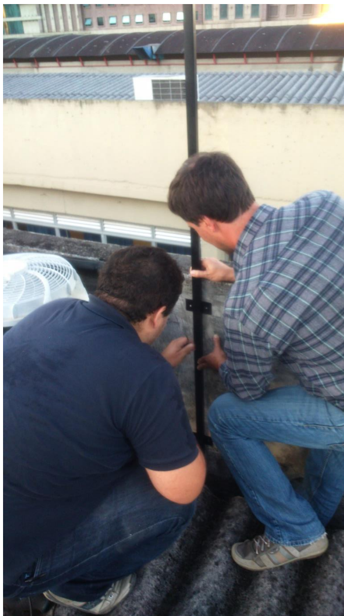
Figura 25 Marcação da parede para confecção dos furos de fixação do suporte Fonte: Acervo da Autora
