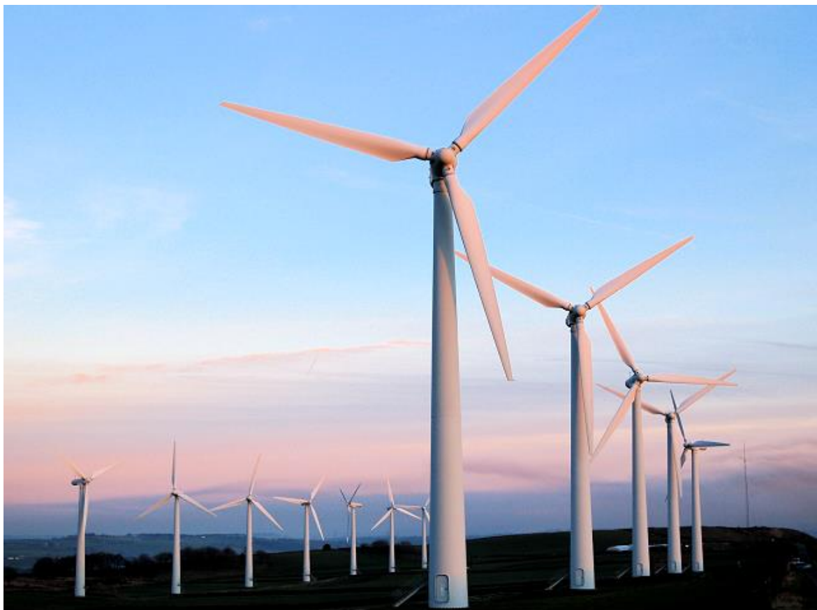
Figura 8 – Aeroogeradores com Rotor de Eixo Horizontal Fonte: Engquímica (2016).
