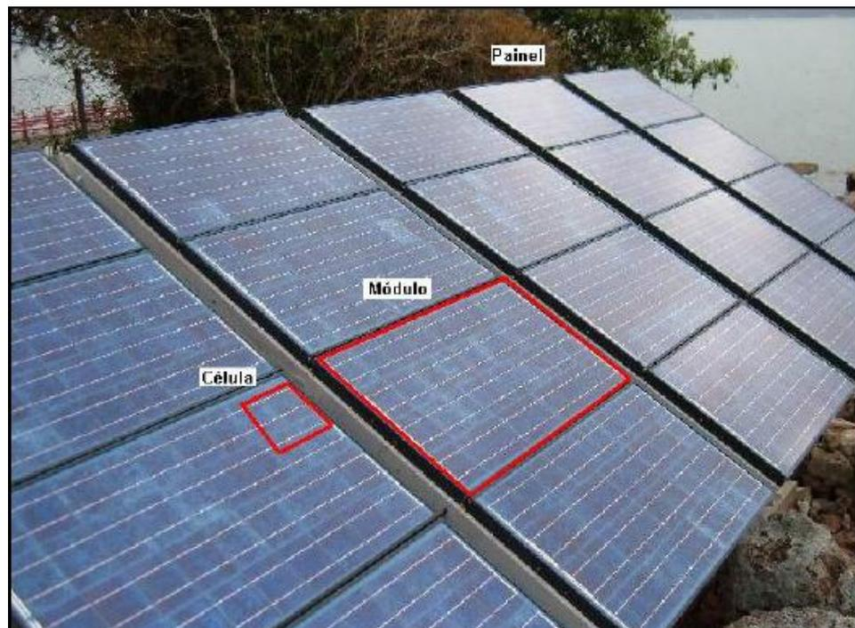
**Figura 15 – Célula, módulo e painel fotovoltaico**
