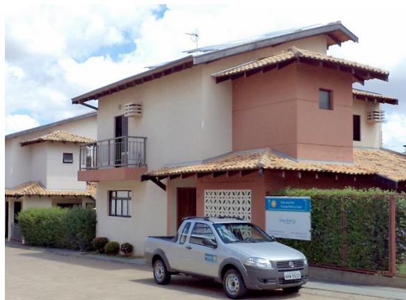
Figura 54 - Painéis instalados no telhado da residência do Ricardo Marcelino Santana. Fonte: adaptado de SOLAR ENERGY, 2014.
