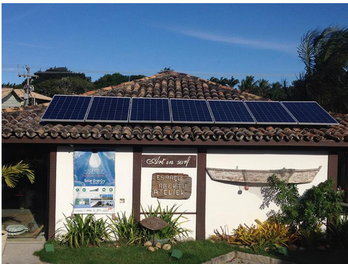
Figura 61 – Instalação de painéis no telhado da loja Art in Surf em Búzios – RJ. Fonte: SOLAR ENERGY, 2014.
