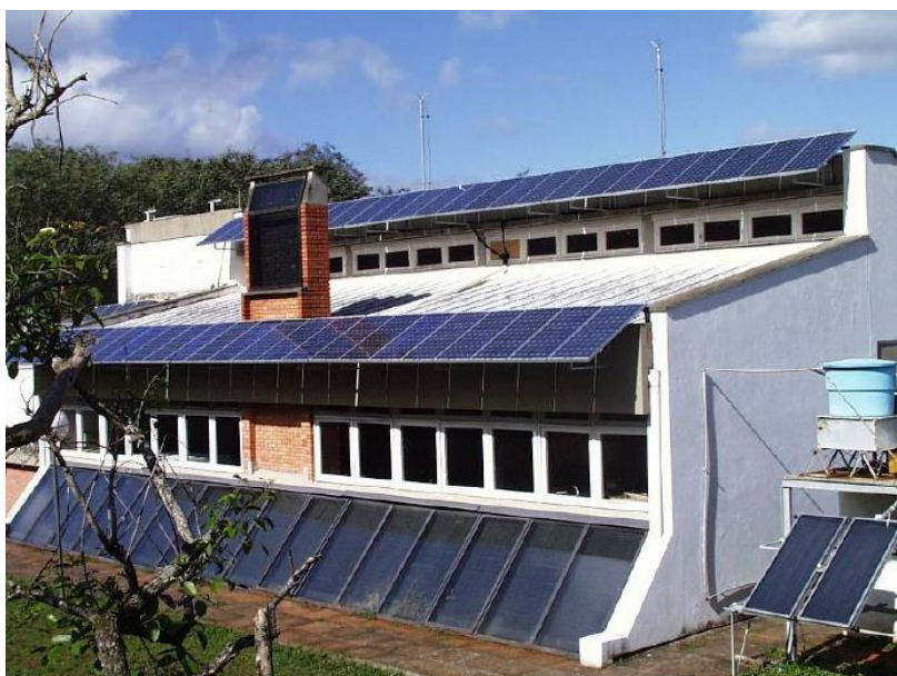
Figura 46 - Módulos fotovoltaicos no prédio do laboratório de energia solar da UFRGS. Fonte: adaptado de URBANETZ,2010.
