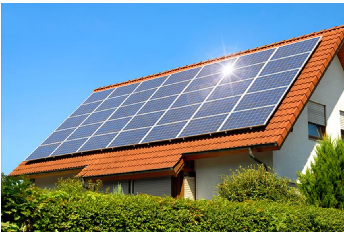
Figura 4 - Módulos fotovoltaicos instalados em uma residência. Fonte: ECOCASA, 2013.
