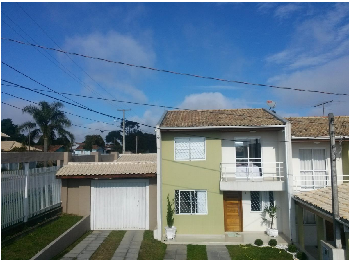
Figura 70 - Detalhe da fachada da residência escolhida para o projeto Fonte: os autores, 2014.
