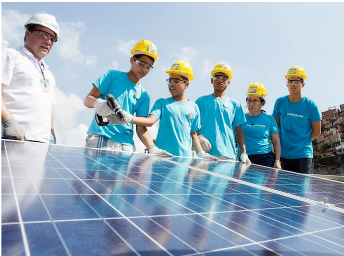
Figura 62 - Instalação dos módulos FV na Vila Isabel. Fonte: SOLAR ENERGY, 2014.
