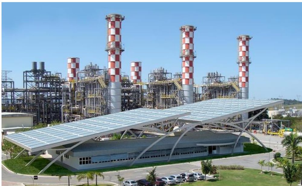
Figura 51 - Sistema Fotovoltaico da UTE Norte Fluminense.
