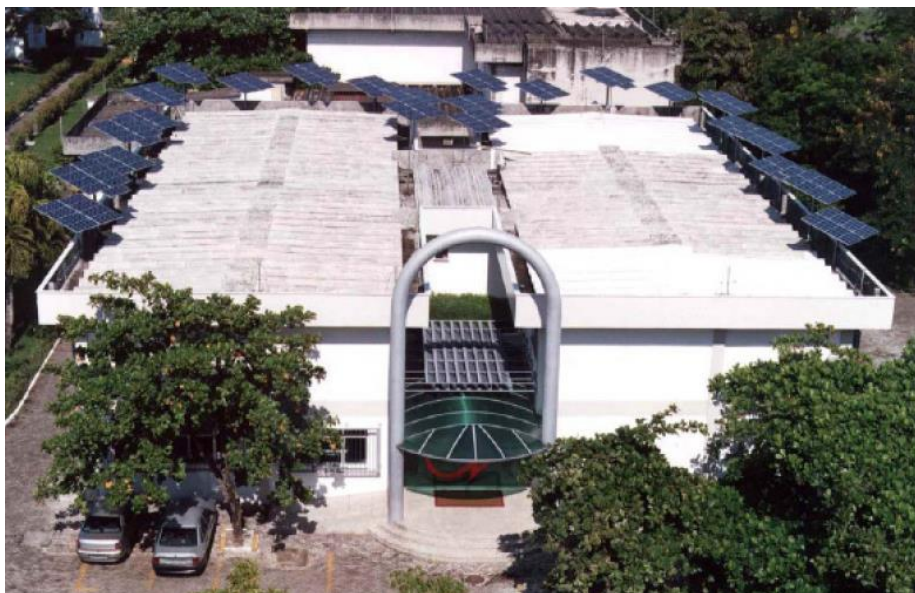
Figura 47 - Vista do prédio do CEPEL no Rio de Janeiro. Fonte: adaptado de URBANETZ JUNIOR, 2010.
