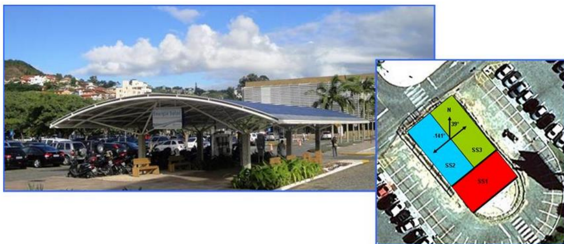
Figura 49 - Módulos fotovoltaicos na sede da ELETROSUL. Fonte: ELETROSUL, 2014.
