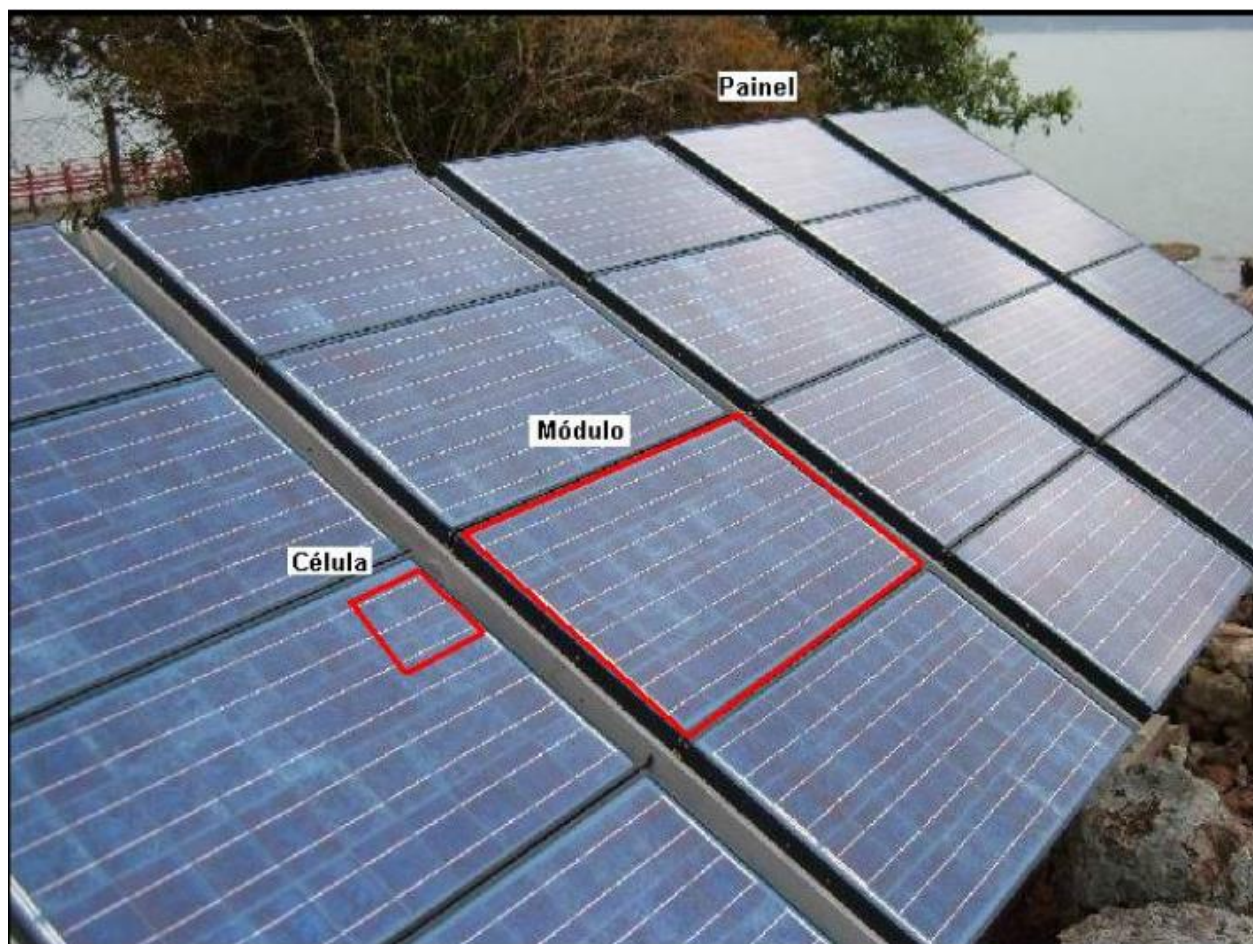
Figura 2 - Vista de painel, módulo e célula fotovoltaica Fonte: URBANETZ JUNIOR, 2010.
