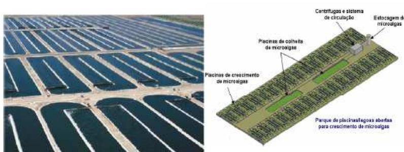
**Figura 11 - Sistemas de produção de microalgas a céu aberto do tipo *raceway pond* (www.was.org).**
