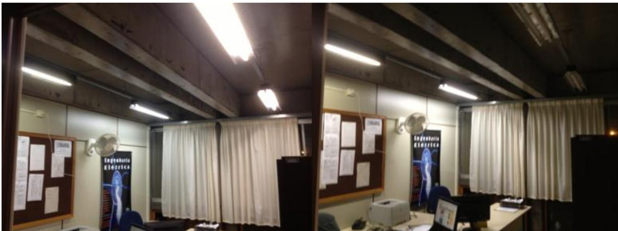
**Figura 23 - Exemplo de não conformidade ao critério de aproveitamento da iluminação natural da sala de coordenação de engenharia do DAELT.**
