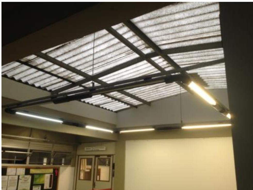
**Figura 14 - Iluminação zenital no bloco D.**
