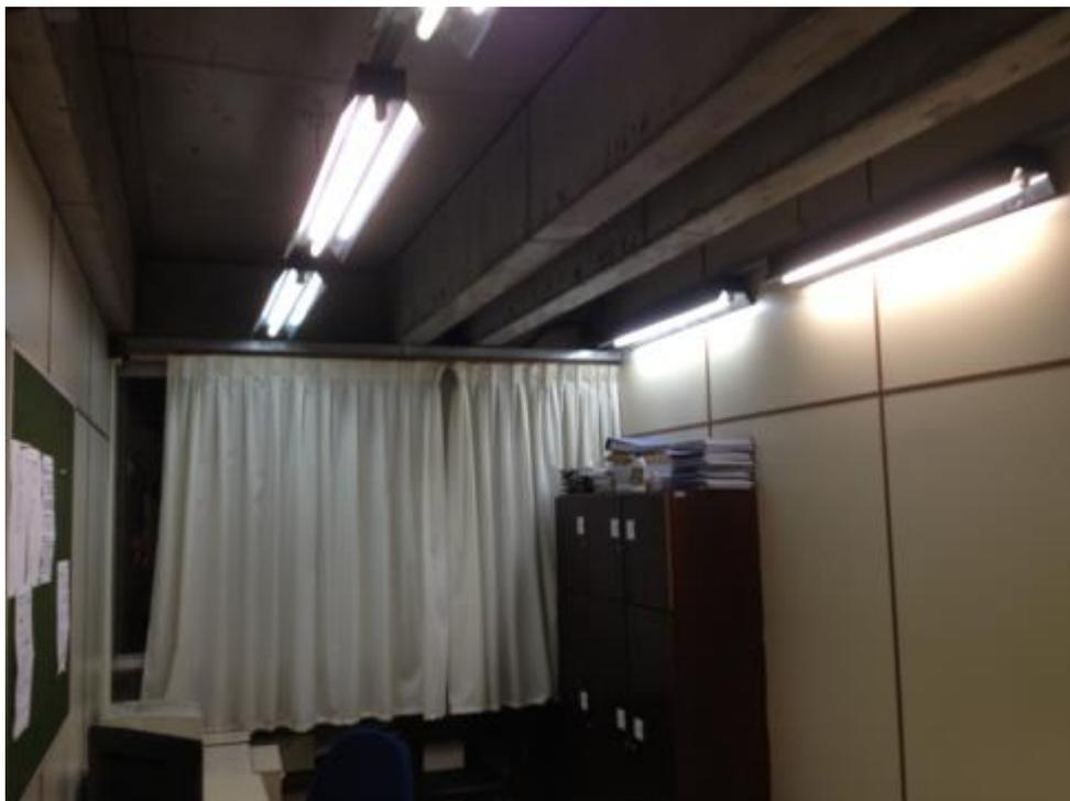
**Figura 27 - Exemplo de má distribuição de luminárias.**
