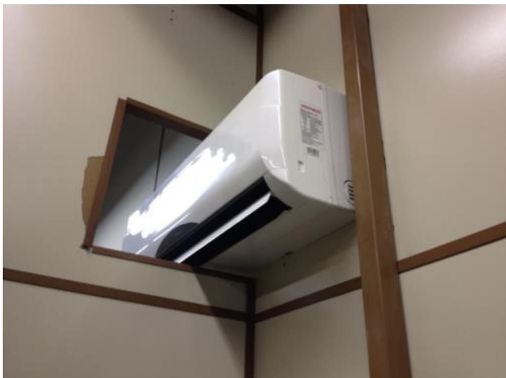
**Figura 26 - Aparelho de ar condicionado dividido entre dois ambientes.
