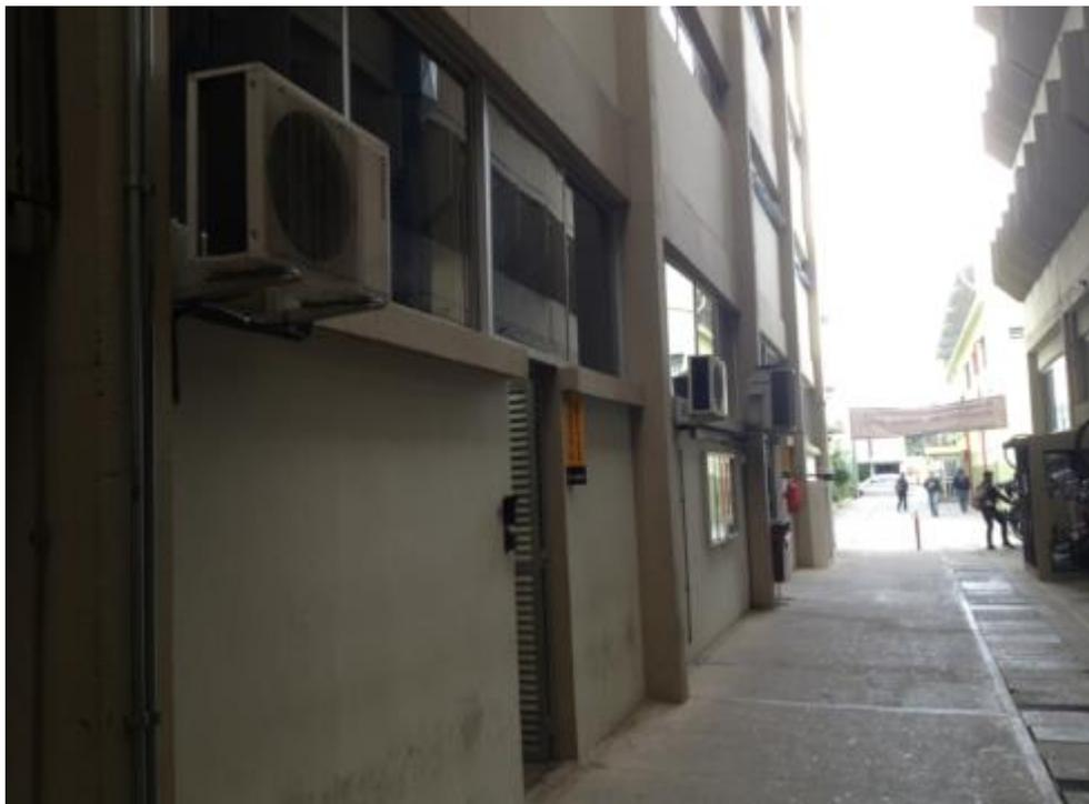
**Figura 29 - Condensadoras sombreadas no corredor entre o bloco C e o bloco D.**
