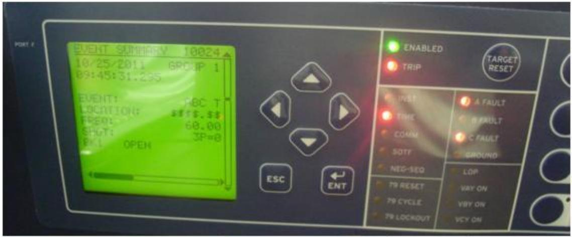
**Figura 35 - Painel frontal após atuação da função 51**
