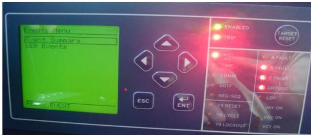
**Figura 26 - Painel frontal após atuação da função 50N**
