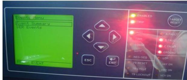
Figura 32 - Painel frontal após atuação da função 50N
