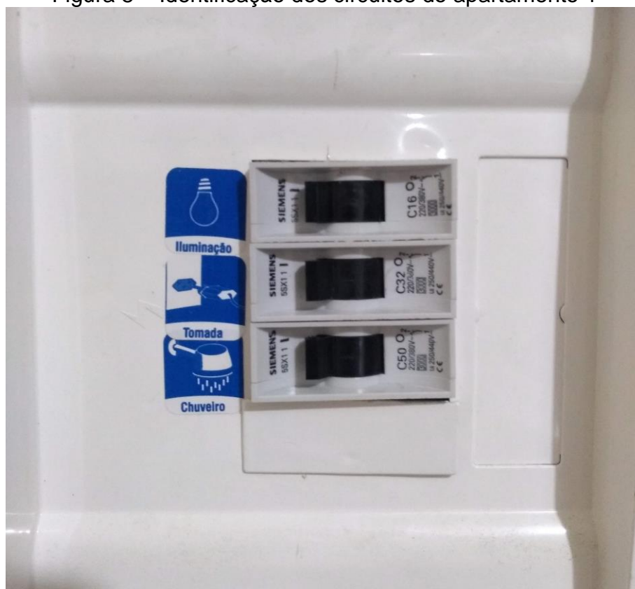
Figura 8 – Identificação dos circuitos do apartamento 1
