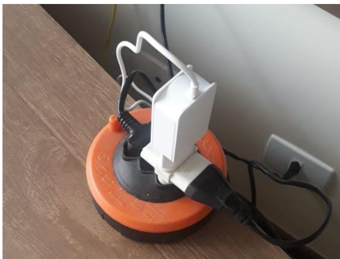
Figura 25 – Extensão e “tês” na sala
