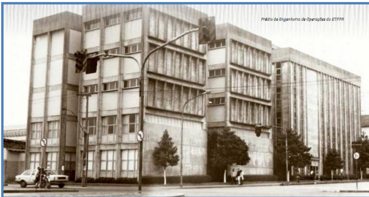
Figura 11 – Prédio de Engenharia de Operações, inaugurado em 1975.
