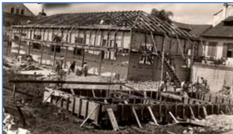
Figura 10 – Obras de ampliação da Escola Técnica de Curitiba.
