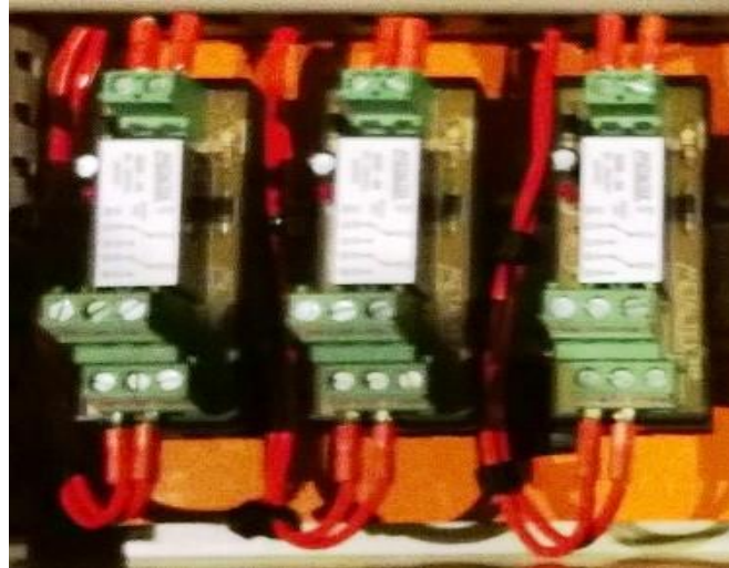
Figura 19 – Disjuntores Fonte: Autoria Própria
