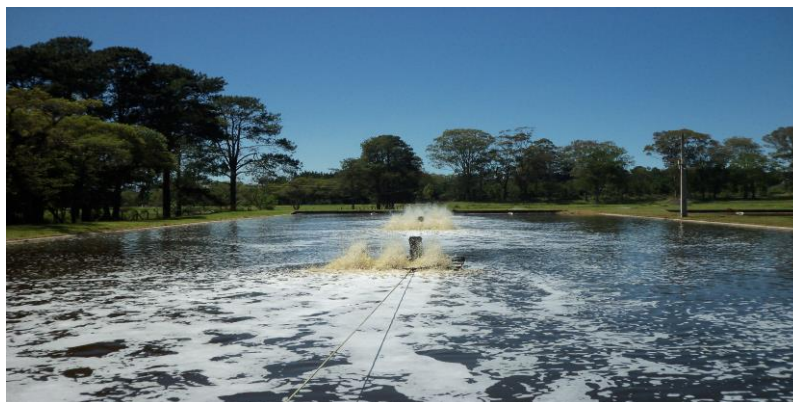
Figura 8 - Lagoa de polimento com aeradores. Fonte: Autoria própria.
