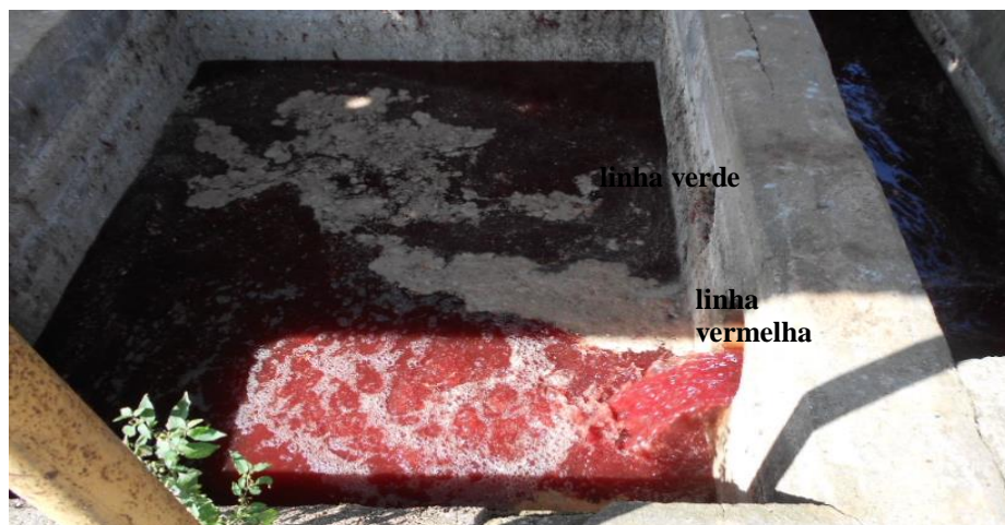
Figura 4 – Tanque de equalização.
