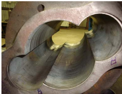
Figura 32 - Corpo da bomba após recuperação. Fonte: Relatório de manutenção da bomba.
