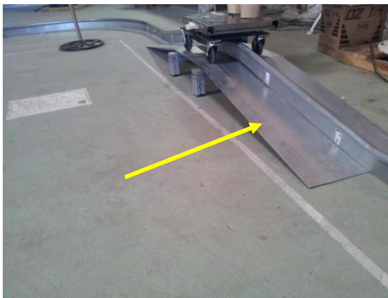
Figura 23 - Rampa montada Fonte: Autoria própria.
