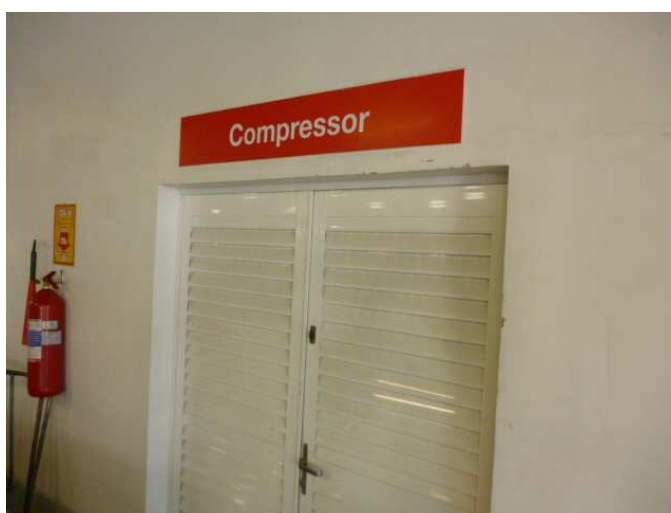
Figura 11 - Casa dos compressores. Fonte: Autores.
