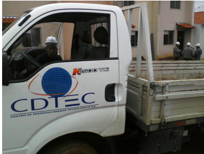
Figura 12 - Coleta dos corpos de prova na obra
