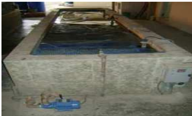
Figura 16 – CPs submersos no tanque de água.
