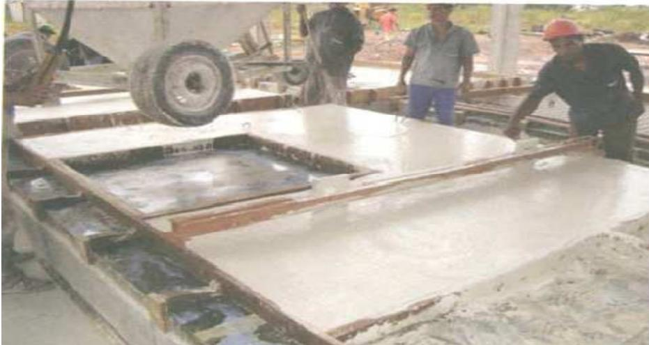
Figura 18 Concretagem pré-moldado, concreto branco, (Fonte TUTIKIAN e DAL MOLIN 2008).
