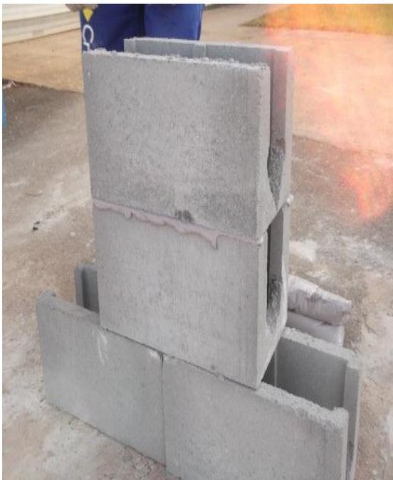
Figura 12 - Exemplo de bom nivelamento dos blocos devido a boa trabalhabilidade da argamassa.
