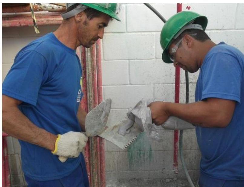
Figura 3 - Argamassa sendo aplicada em assentamento de azulejo
