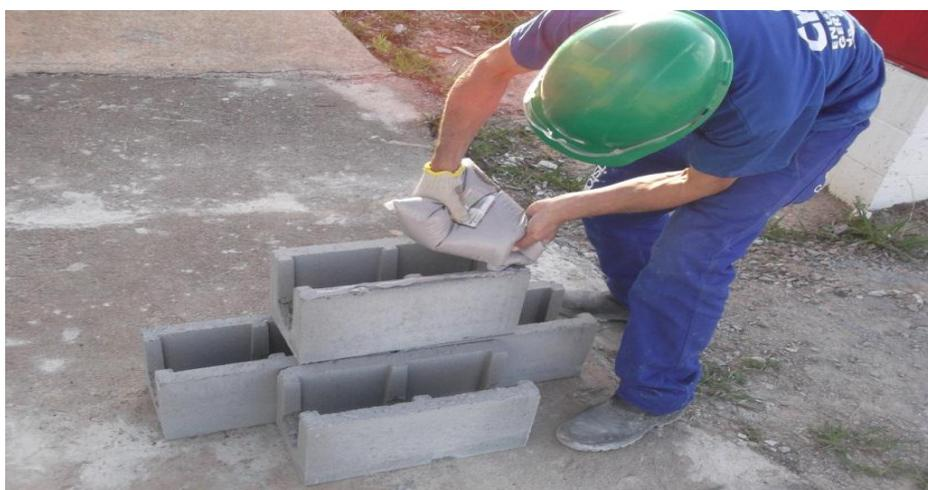
Figura 9 - A argamassa industrializada já vem pronta, pode ser utilizada diretamente a partir do pacote.
