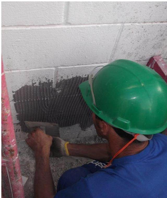
Figura 4 - Argamassa sendo aplicada em uma superfície vertical mostrando boa aderência da argamassa ao substrato.
