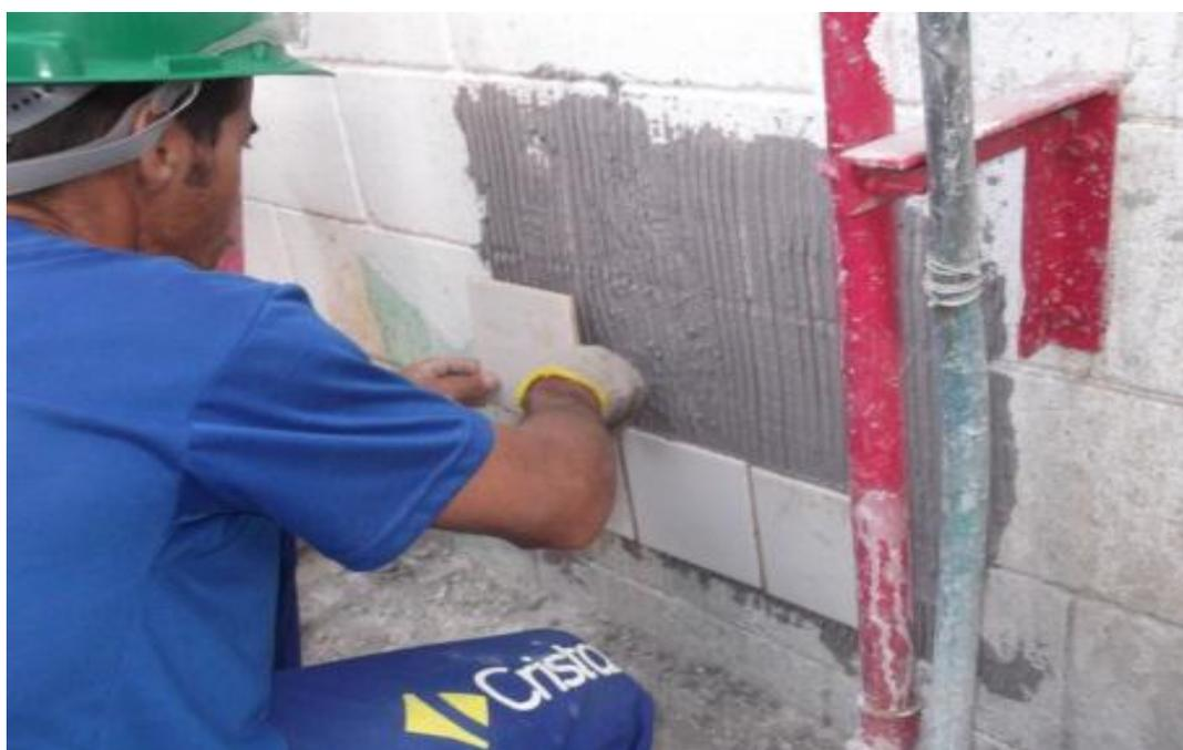
Figura 5 - Assentamento do azulejo em uma superfície vertical mostrando boa aderência com a argamassa.
