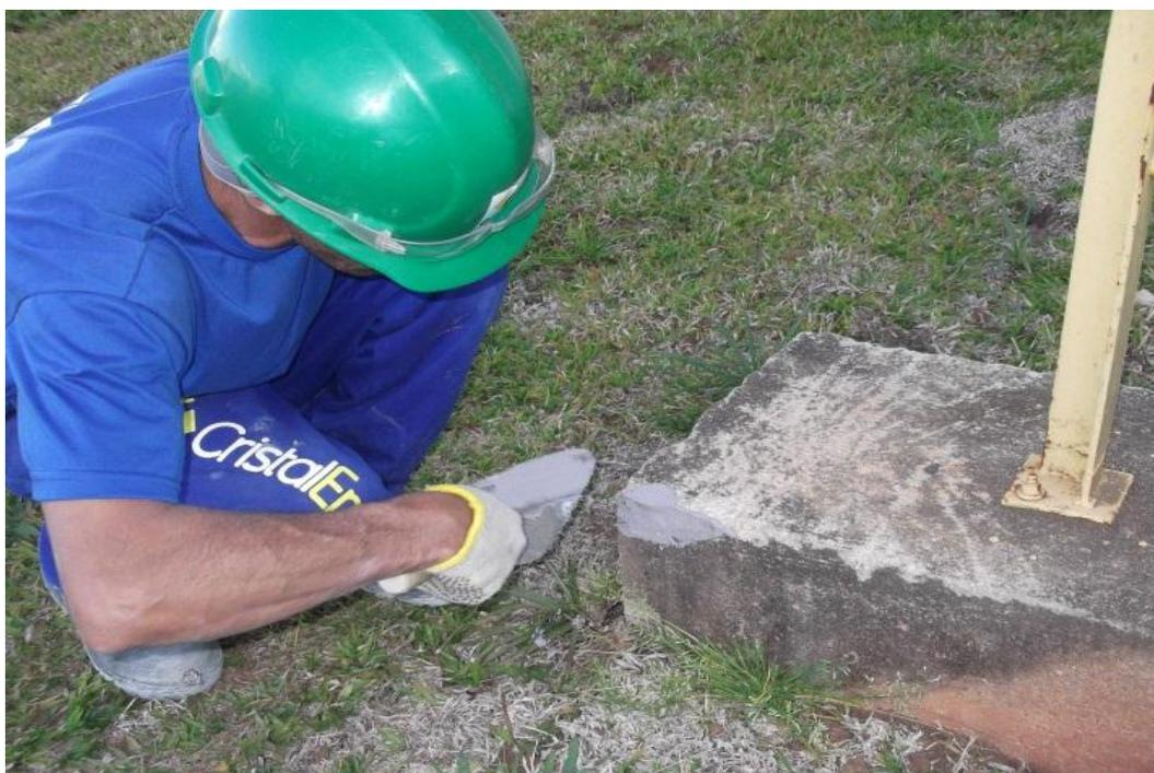
Figura 7 - Argamassa sendo utilizada para reparos em bases de concreto.
