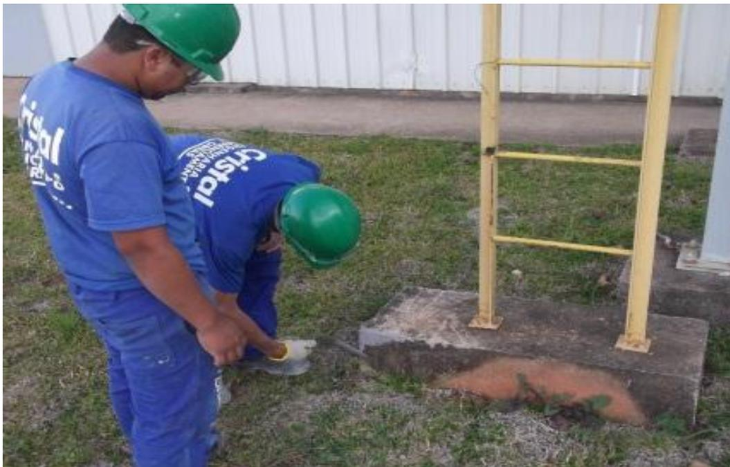
Figura 6 - Argamassa sendo utilizada para reparos em bases de concreto.
