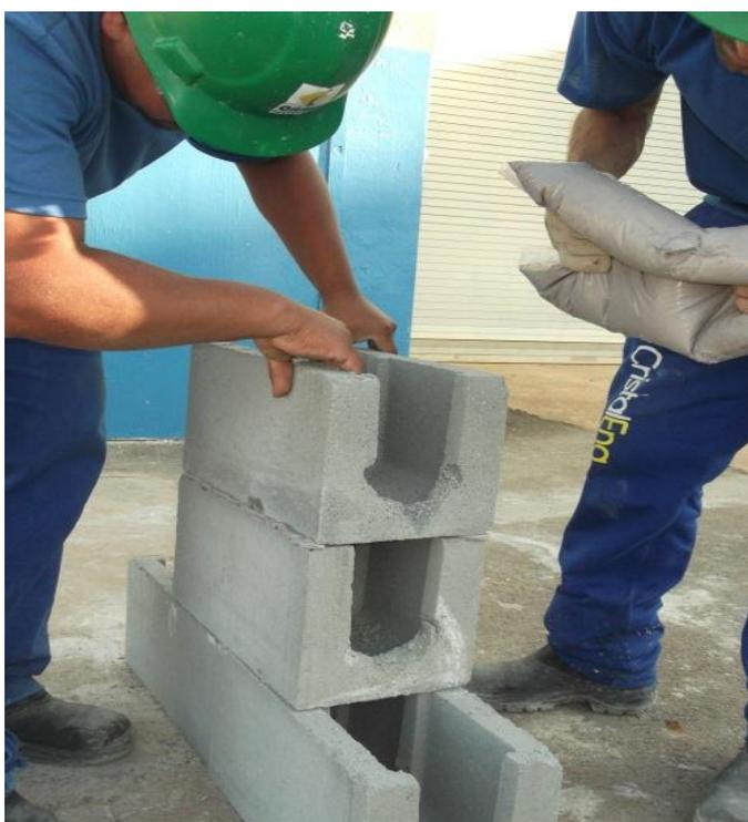
Figura 11 - Exemplo de assentamento de bloco de concreto
