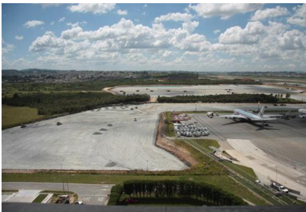
FIGURA 3.18 – Vista Aérea da Ampliação do Aeroporto de Guarulhos.
