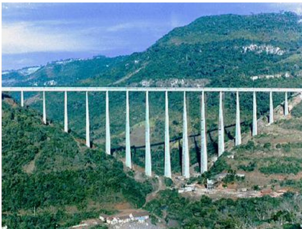
Figura 2.3 – Viaduto do Exército
