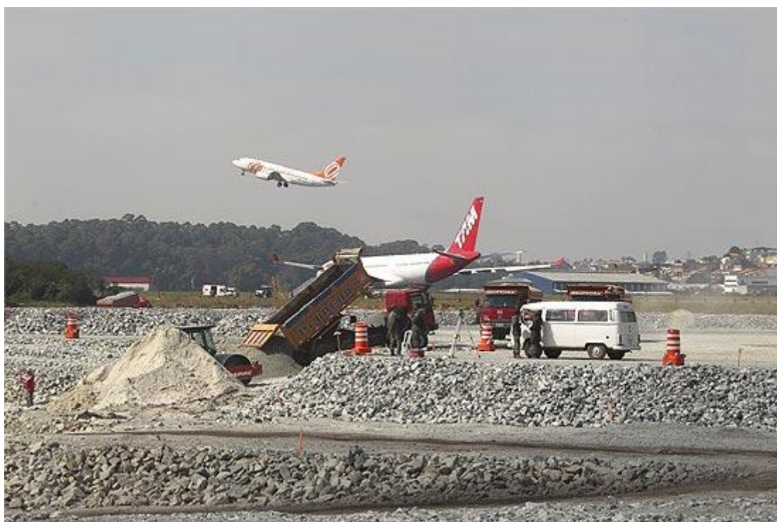
FIGURA 3.19 – Militares na obra do Aeroporto de Guarulhos.
