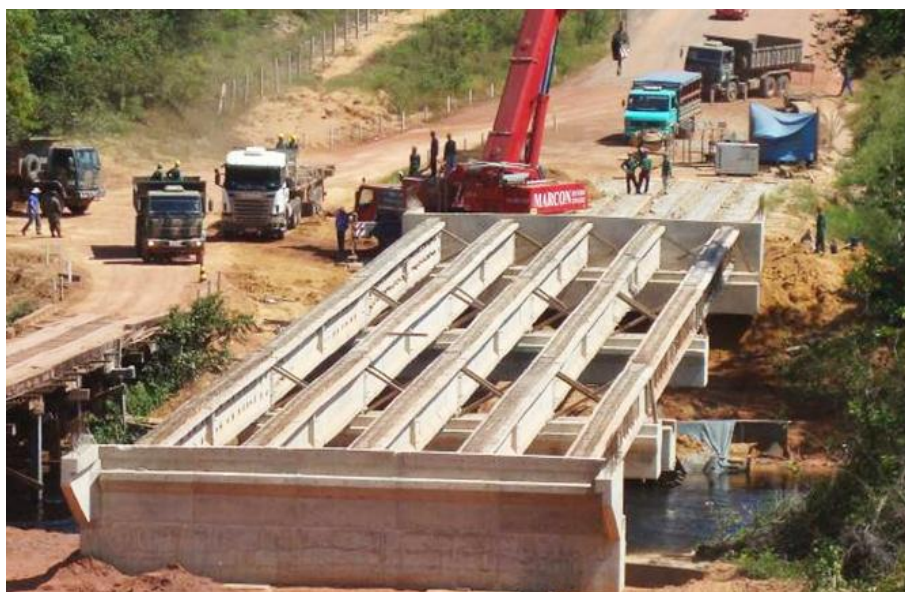
FIGURA 3.15 – Ponte Rio Tuerê – BR-163 / PA
