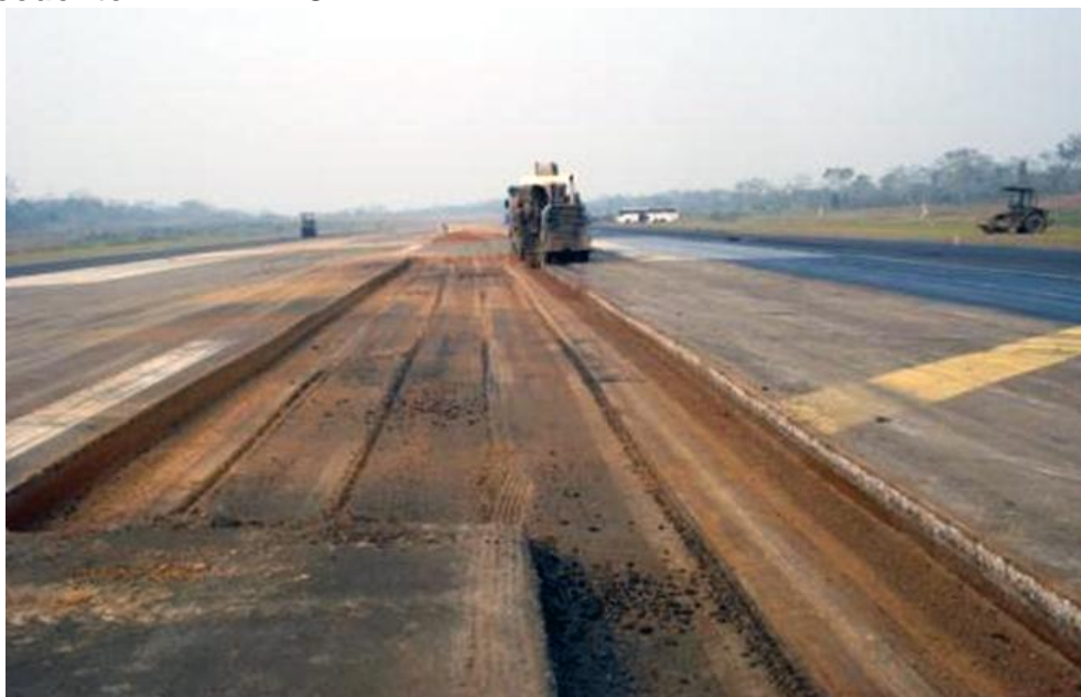
FIGURA 3.12 – Recuperação do Aeroporto Rio Branco / AC
