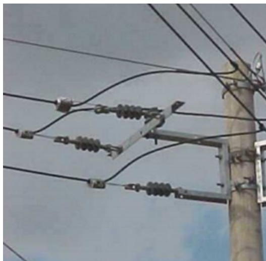
Figura 5. Isoladores com revestimento de SR na rede de energia elétrica. Fonte: Souza (2015).
