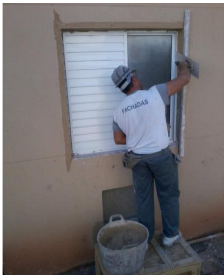
Foto 4 – Trabalhador executando retoque na fachada
