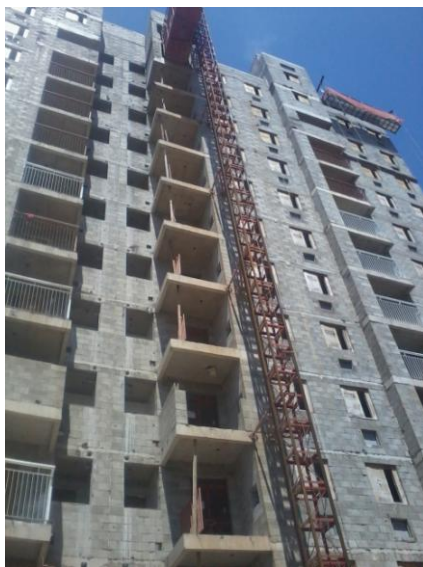
Foto 1 – Fachada de uma obra em alvenaria estrutural
