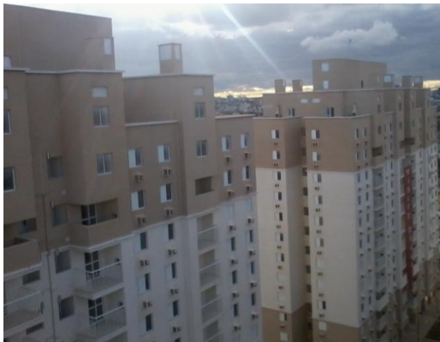
Foto 2 – Fachada de uma obra em alvenaria estrutural revestida com monocapa
