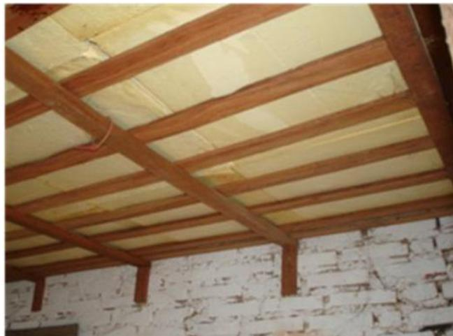
**Figura 8 - Forro da espuma de poliuretano derivado de óleo de mamona utilizado como isolante térmico**
