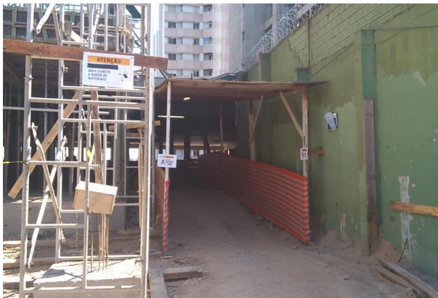
Figura 14: Utilização de madeira para instalações provisórias na Obra F. Fonte: Autoria própria
