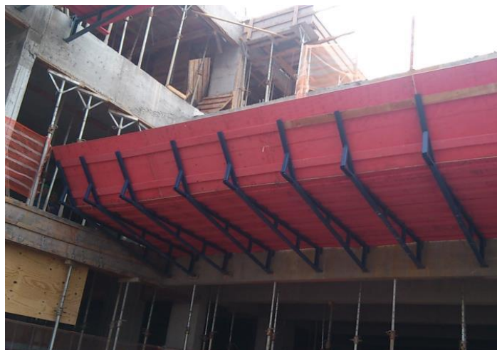
Figura 10: Bandeja de segurança na Obra D.
