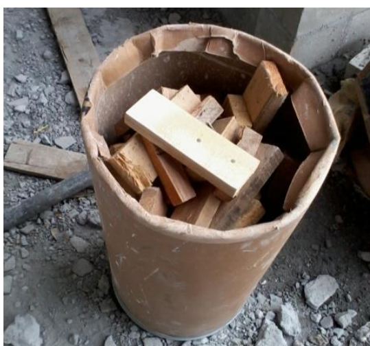
Figura 5: Armazenamento de resíduos de pequenas dimensões na Obra A.
