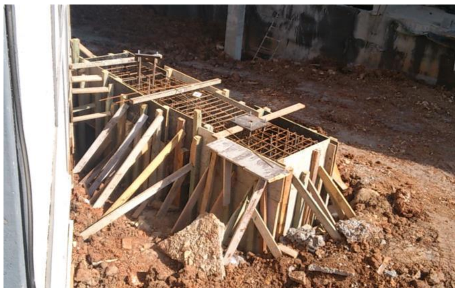
Figura 13: Utilização de madeira para forma de infraestrutura Obra F.
