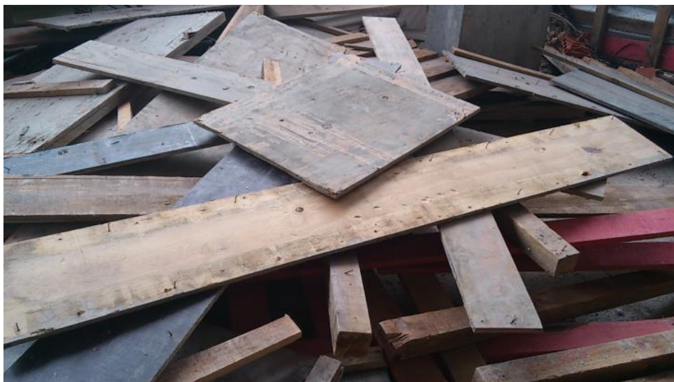
Figura 11: Resíduos provenientes de forma na Obra D.
