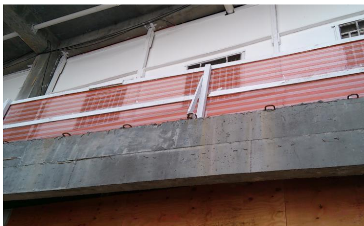
Figura 7: Exemplo de utilização de madeira em instalações provisórias na Obra B.
