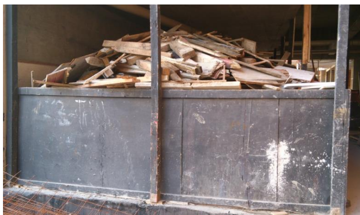
Figura 6: Baia para armazenamento de resíduos de madeira na Obra B.
