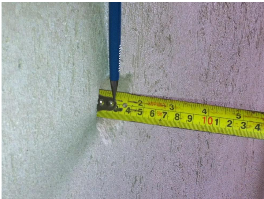
Figura 20 - Anotação da espessura de emboço Fonte – Autoria própria
