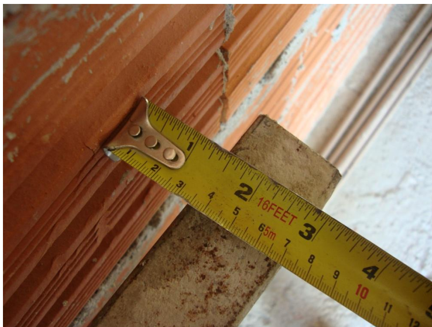
Figura 16 - Medição da diferença de esquadro Fonte – Autoria própria
