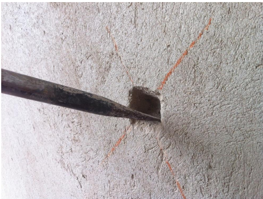
Figura 19 - Abertura para medição do emboço Fonte – Autoria própria
