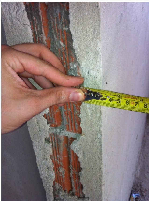
Figura 18 - Medição da espessura de emboço em vão de porta Fonte – Autoria própria
