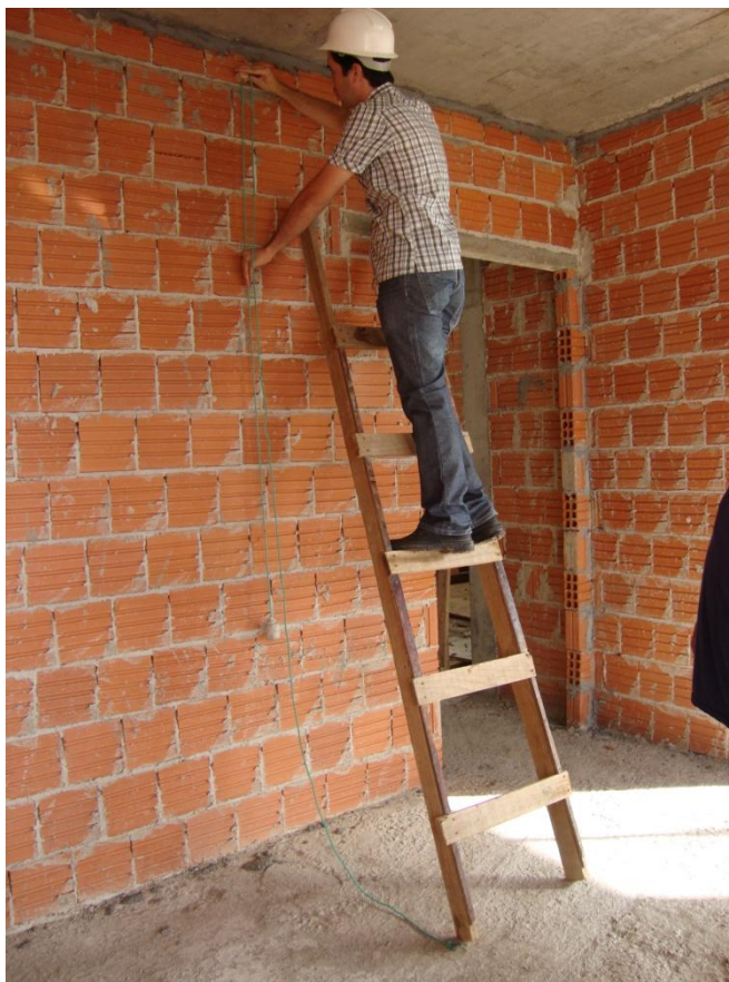
Figura 13 - Verificação do prumo Fonte – Autoria própria
