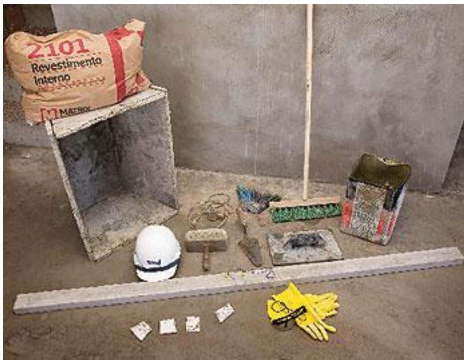
Figura 3 - Materiais e ferramentas para execução de emboço interno Fonte: Figuerola (2006)
