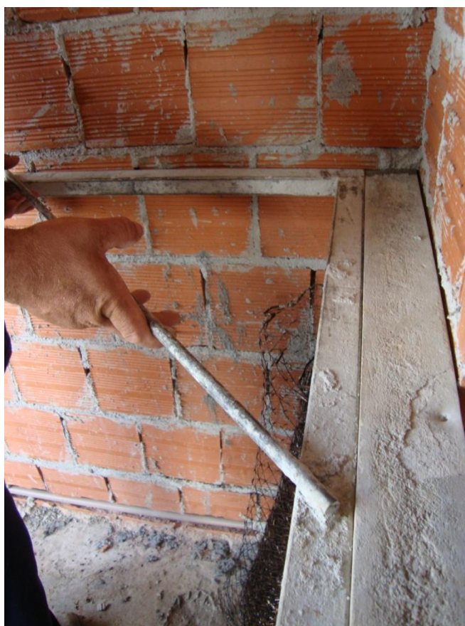
Figura 15 - Verificação do esquadro Fonte – Autoria própria
