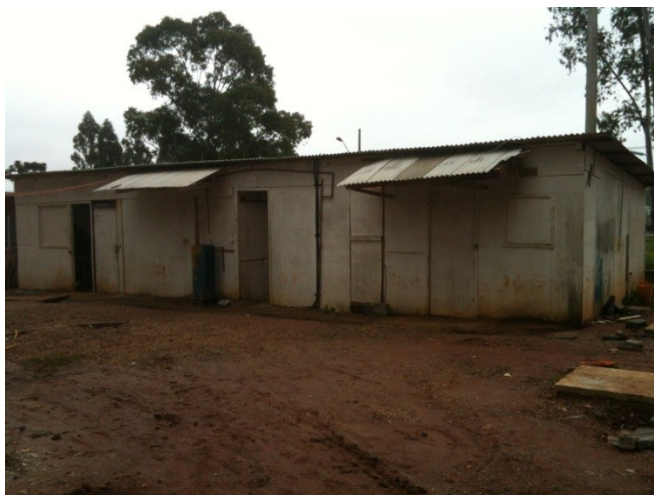
Figura 7 – Vista da edícula contendo escritório, bebedouro, sanitários e vestiário 1. Fonte: O autor (2012)
