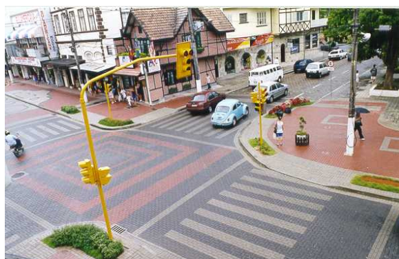
Figura 4.2 – Vista de um cruzamento executado com paver em Blumenau.
