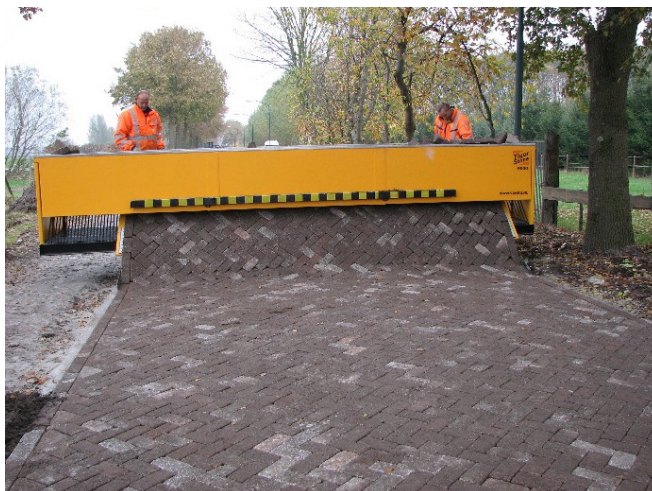
Figura 2.5 – Assentamento mecanizado de pavers utilizado na Holanda Fonte: http://www.tiger-stone.nl/index.php?option=com_content&view=article&id=47&Itemid=55 (Acesso em 19/11/2011)
