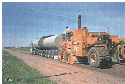
Figura 2.16 – Exemplo de reciclagem in situ
