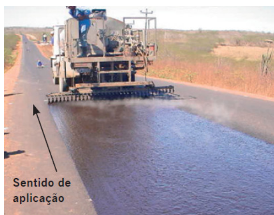
Figura 2.20 – Execução da pintura de ligação ou imprimadura Fonte: Bernucci (2007, p. 394)
