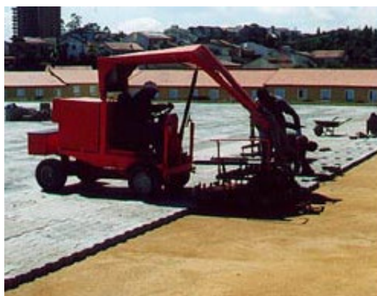
Figura 2.4 – Assentamento mecanizado de pavers
