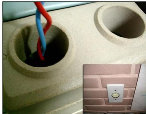
**Figura 14: Fiação embutida. Fonte: Ecoogreen Tijolos Ecológicos**
