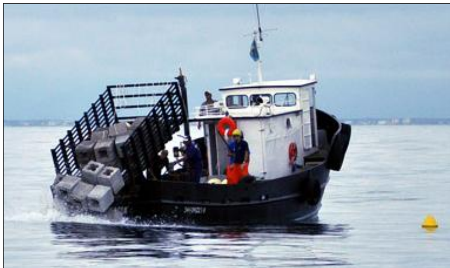
Figura 17: Lançamento de recifes pré-moldados do Programa REBIMAR
