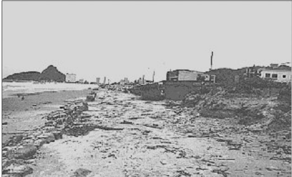
Figura 2: Calçada destruída após tempestade ocorrida em 1979
