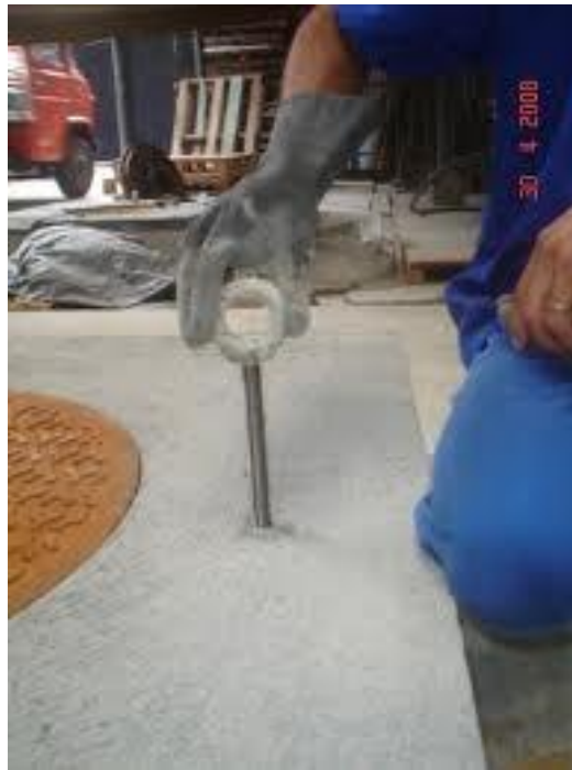
Figura 33: Modelo de Olhal para fixação nas peças.
