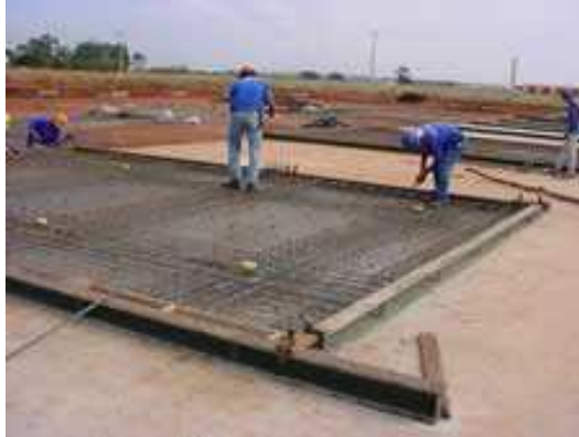
Figura 18: Preparo de fôrma metálica
