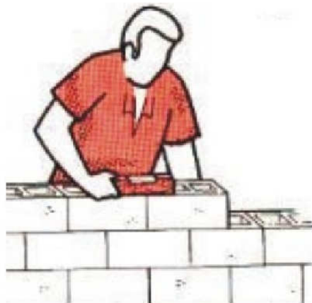
Figura 11 - Verificação do nível das fiadas
