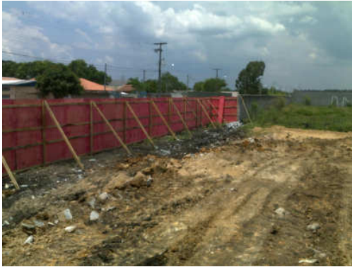
Tapume muro parte 2
