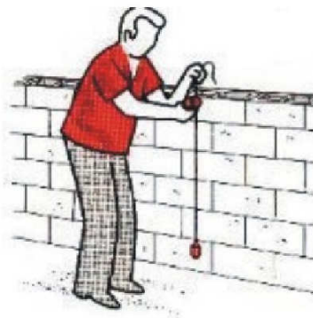
Figura 9 - Verificação do prumo
