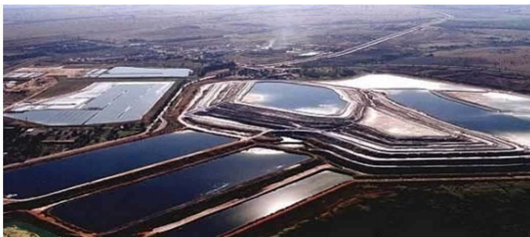
Figura 4 – Lagoas de sedimentação
