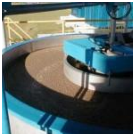
Figura 4 – Sistema de flotação por ar dissolvido.
