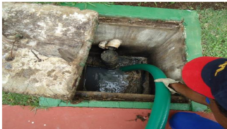
Figura 3 – Limpeza de uma caixa de gordura moldada in loco. Fonte: Gasperi (2012)
