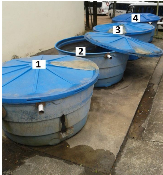
Figura 12 – Caixas utilizadas no tratamento do efluente de lavagem de veículos. Fonte: Autoria própria
