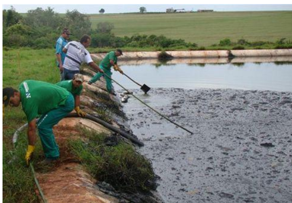
Figura 2 - Retirada de óleo da lagoa de tratamento da ETE de Sarandi-PR Fonte: Carvalho (2010).
