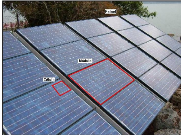
Figura 14 - Painel, módulo e célula fotovoltaica Fonte: Urbanetz (2010).
