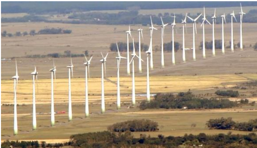
Figura 18 – Complexo eólico de Osório-RS.
