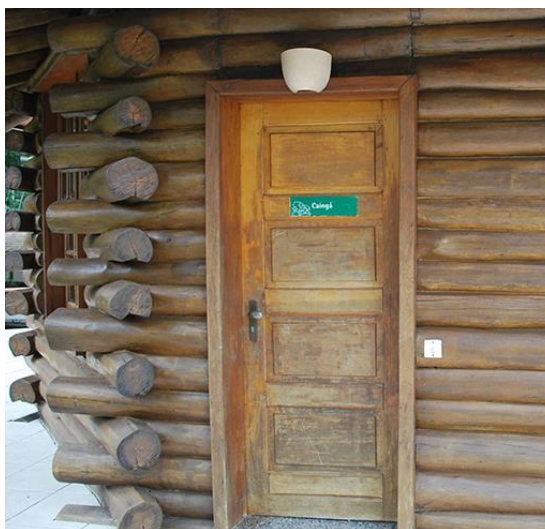
Figura 8 - Detalhe da interseção de troncos para construção de paredes Fonte: Zuccaratto (2017)
