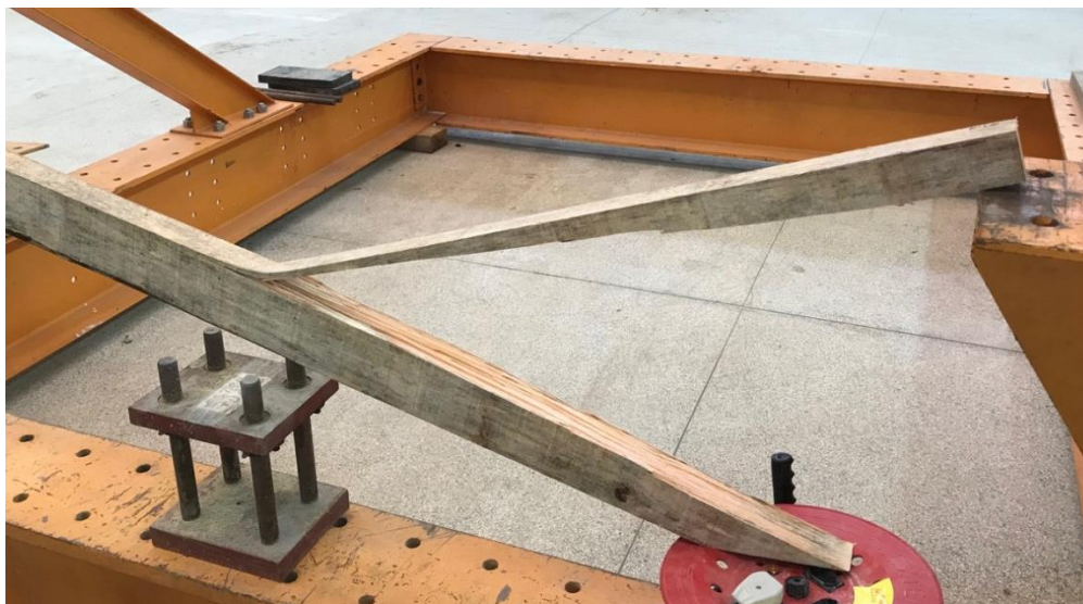
Figura 33 - Ruptura da viga AM03
