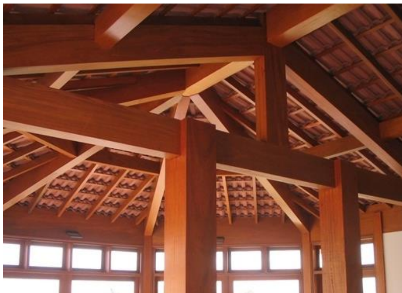
Figura 4 - Entalhe para ligação viga-pilar Fonte: Madegrande Madeiras (2017)
