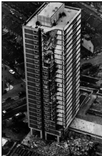
Figura 4 - Edifício Ronan Point após o colapso Fonte: Verlaan (2011)
