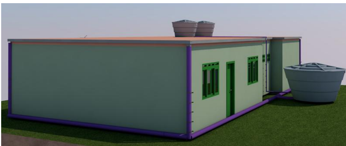
Figura 22 - Vista lateral de casa de habitação com instalações do sistema de aproveitamento de água da chuva referente ao cenário 1
