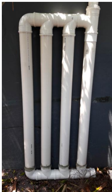
Figura 11 – Dispositivo de descarte de primeira chuva. Fonte: Aatoria própria (2016).
