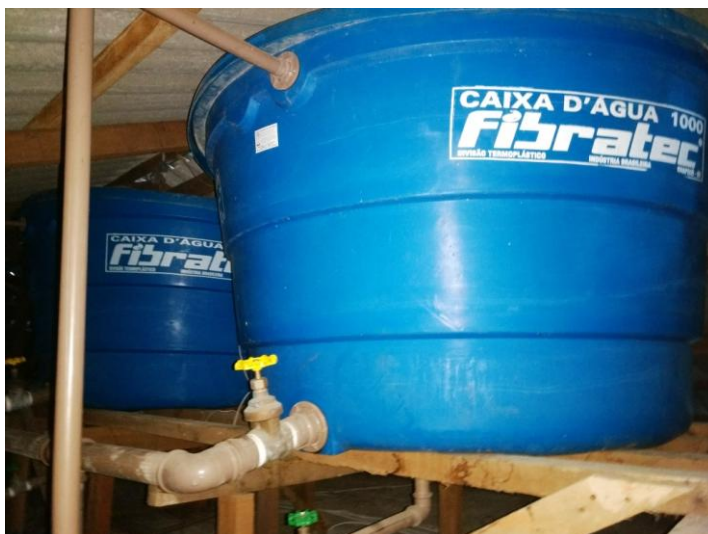
Figura 17 – caixa d'água presente na cobertura das habitações Fonte: Autoria própria (2016).
