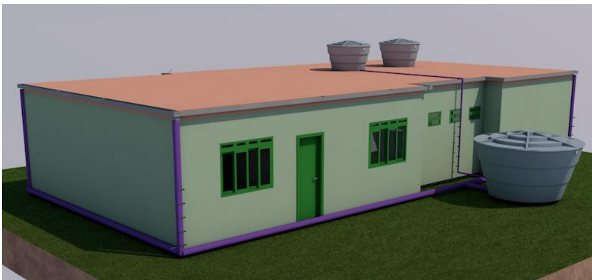
Figura 23 - Vista dos fundos de casa de habitação com instalações do sistema de aproveitamento de água da chuva referente ao cenário 1
