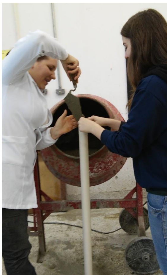
Figura 10 - Concretagem do pilar
