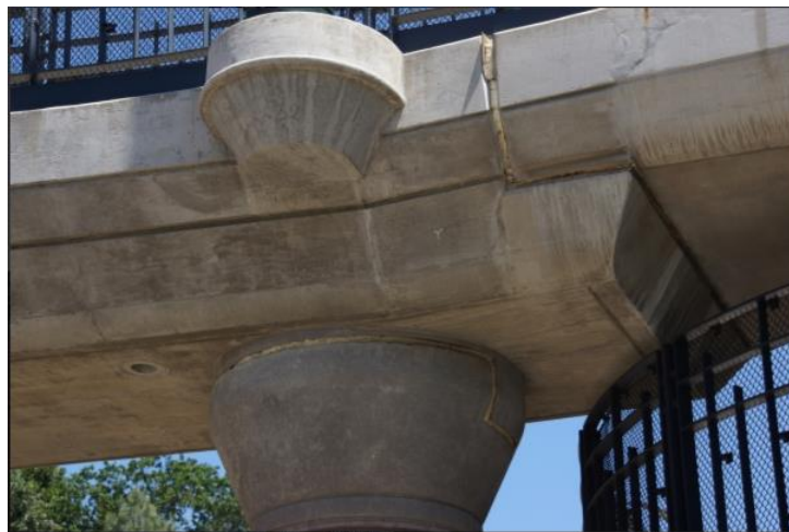
Figura 1: Apoio de uma passarela em viga com dente Gerber. Fonte: Structurae
