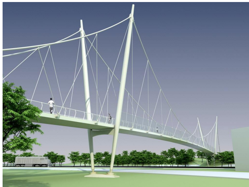
Figura 6: Passarela pênsil. Fonte: blog Cleveland.
