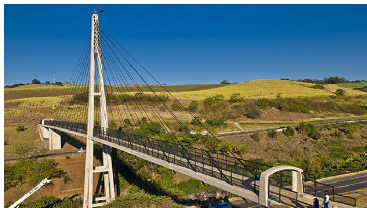
Figura 7: Passarela estaiada Blackburn, na África do Sul. Fonte: Royal Haskoning.
