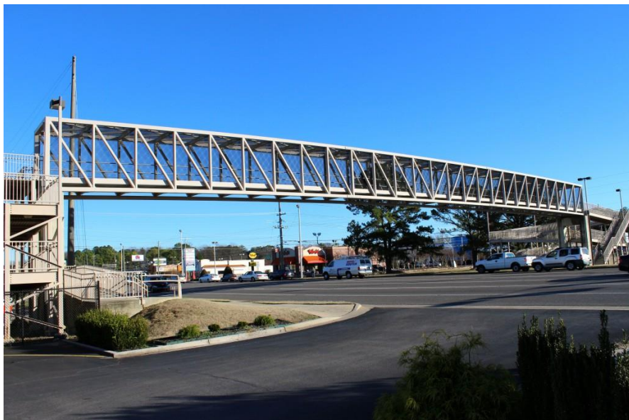
Figura 5: Passarela Cathedral Caverns , em estrutura treliçada. Fonte: Miller-Miller
