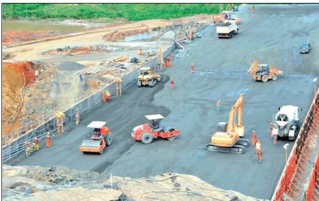
Figura 2.2 – Execução de CCR na barragem da UHE Mauá, no Paraná.
