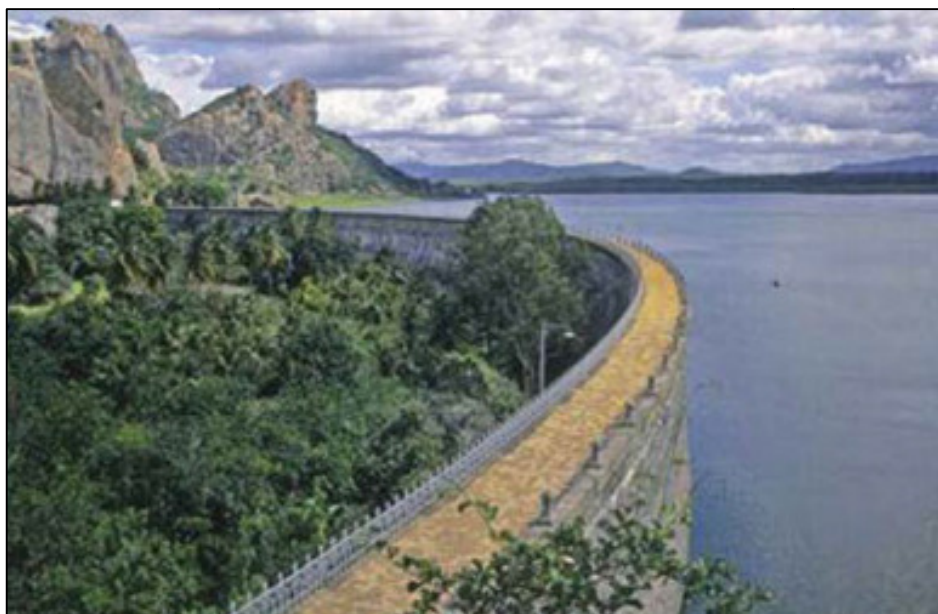
Figura 2.1 – Barragem de Cedros, no Ceará. Fonte: Comitê Brasileiro de Barragens, 2011.
