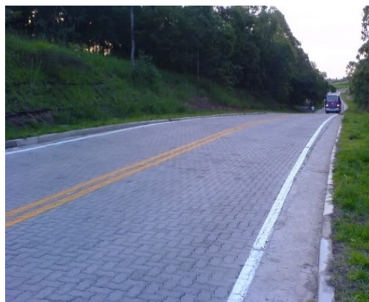
Figura 5 – Pavimentação intertravada na rodovia Visconde de Porto Seguro (SP-332), entre as cidades de Valinhos e Campinas (SP)
