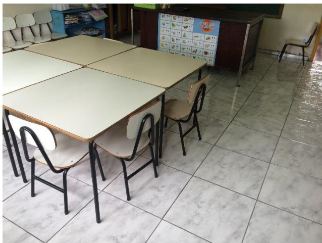
Figura 11 - Piso cerâmico - Sala do Pré 1 Fonte: As autoras (2016)
