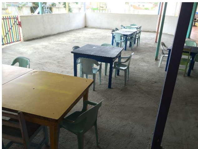
Figura 13 - Contrapiso da área coberta Fonte: As autoras (2016)
