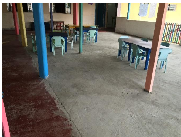
Figura 14 - Contrapiso da área coberta Fonte: As autoras (2016)
