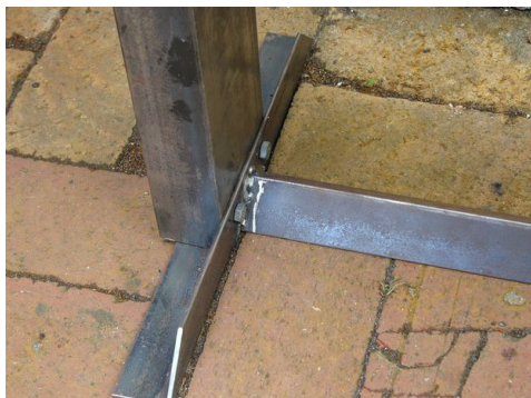
Figura 44 - Base Prensa Hidráulica Caseira.
