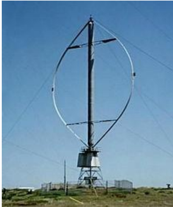
Figura 10 – Turbina de Darrieus. Fonte:REUK 2009
