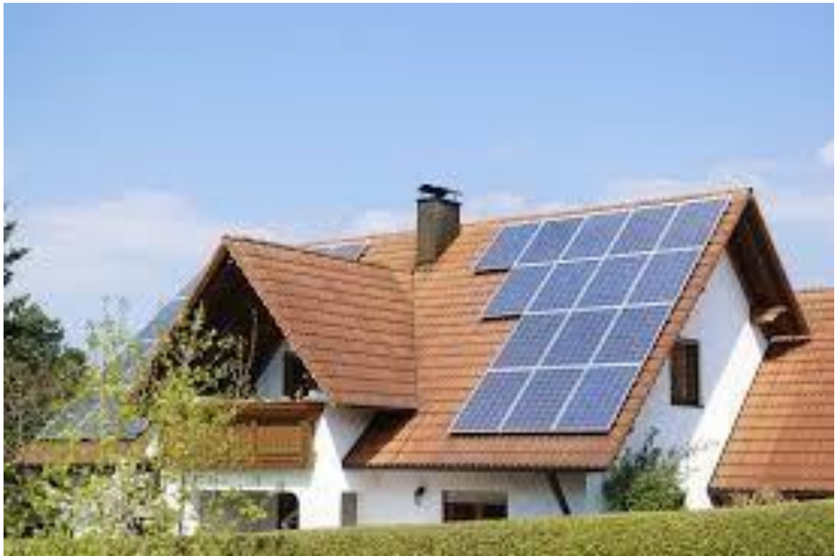
Figura 4 - Painéis fotovoltaicos. Fonte: Ecovolts 2014
