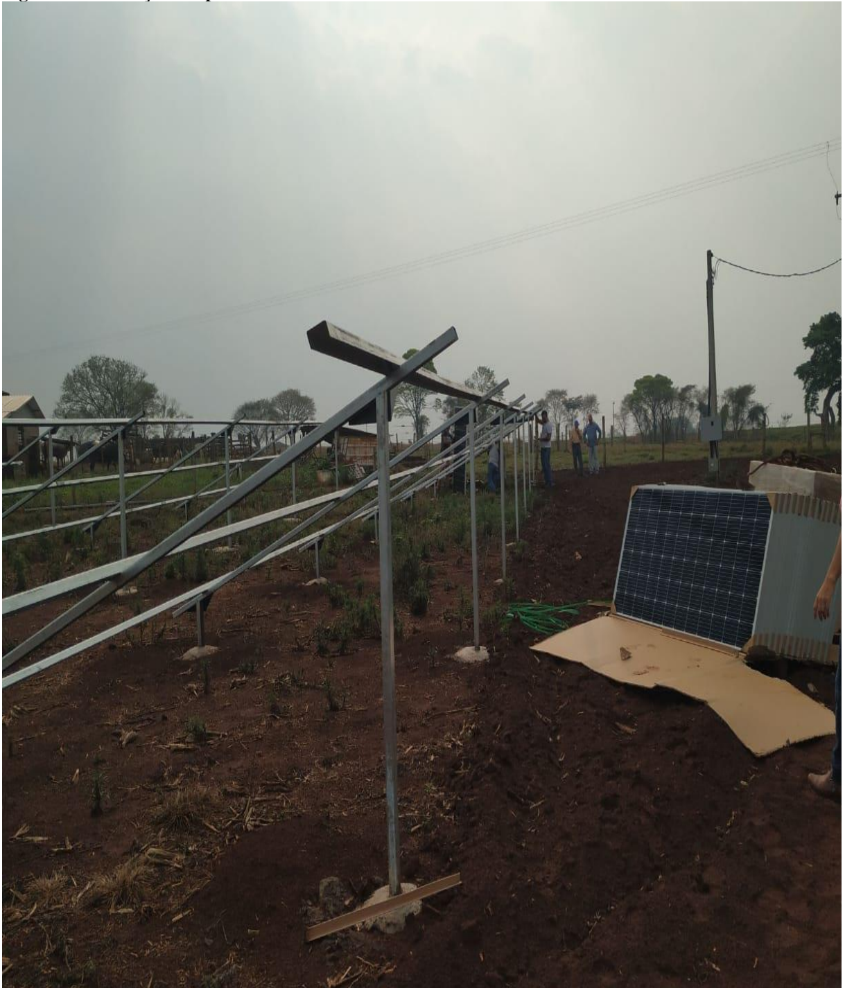
Figura 4 – Instalação dos painéis fotovoltaicos
