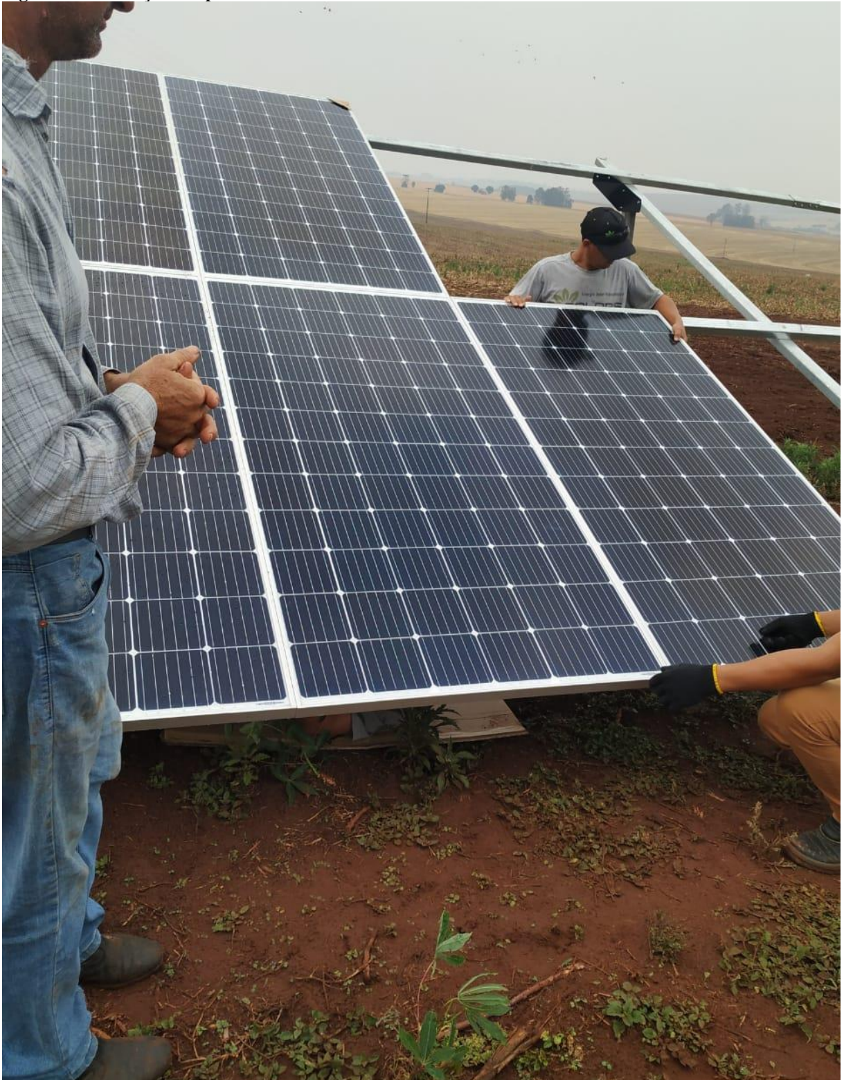
Figura 5 – Instalação dos painéis fotovoltaicos
