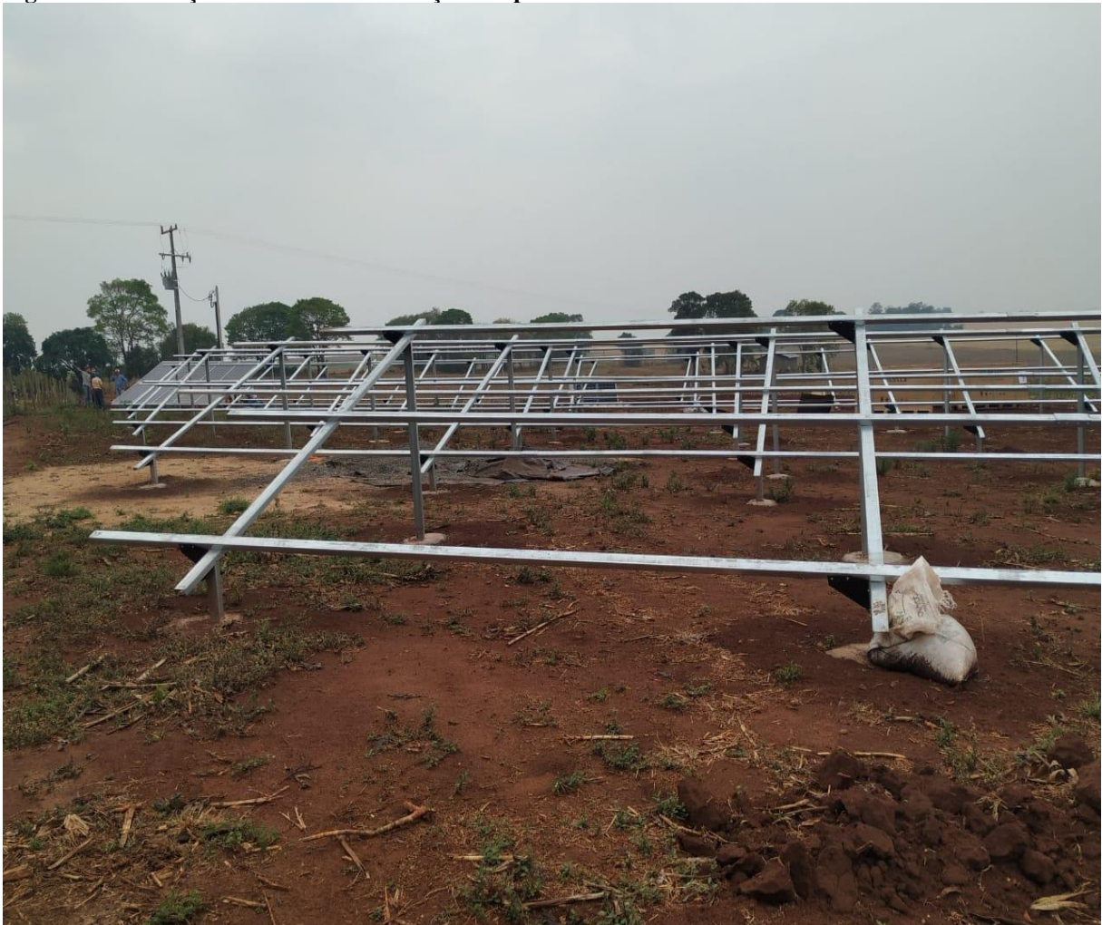
Figura 3 – Instalação da estrutura de fixação dos painéis fotovoltaicos
