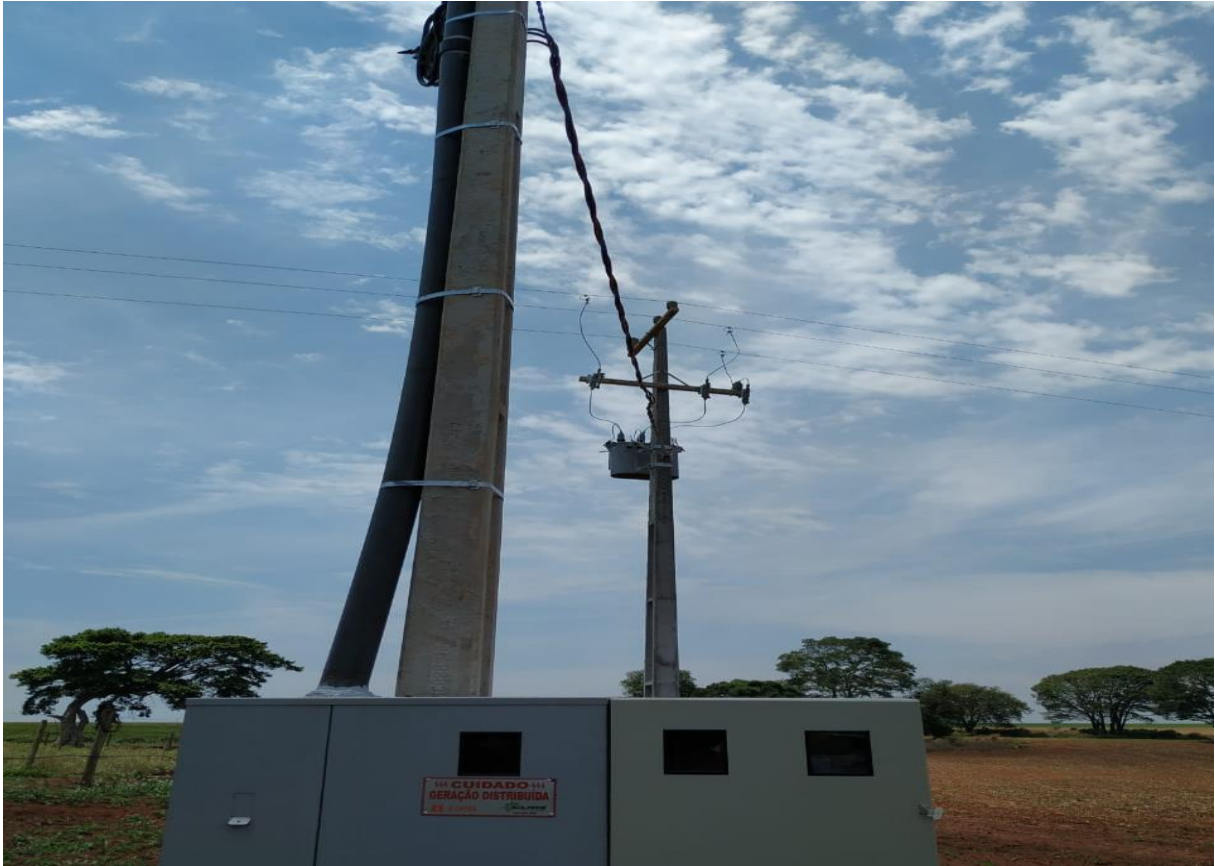
Figura 9 – Registro de luz ligado ao poste que demanda a energia direta à rede
